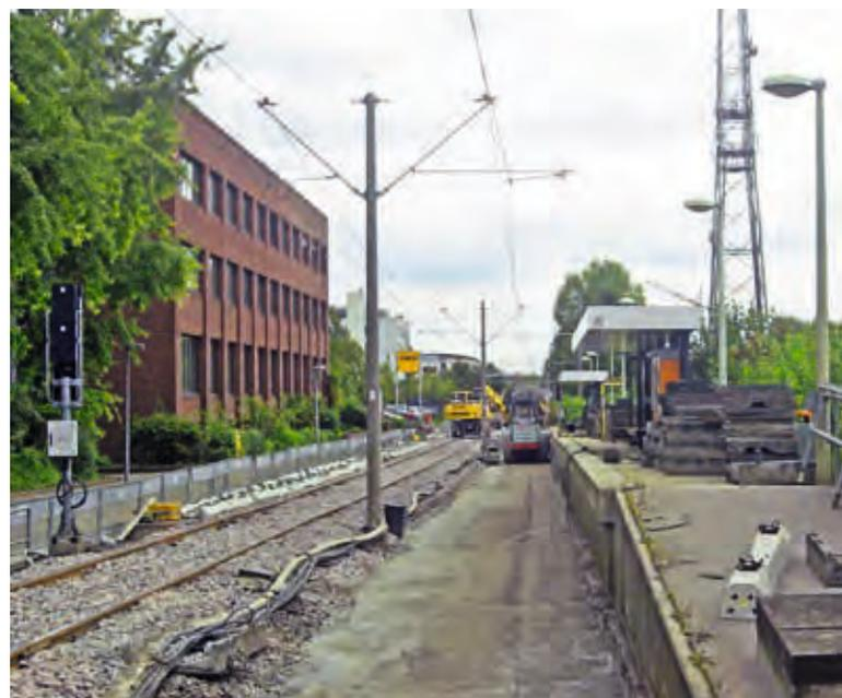
Provisorische Hochbahnsteige auf dem SSB-Gelände // Sanierung des Oberbaus zwischen den Haltestellen SSB-Zentrum und Vaihinger Straße
