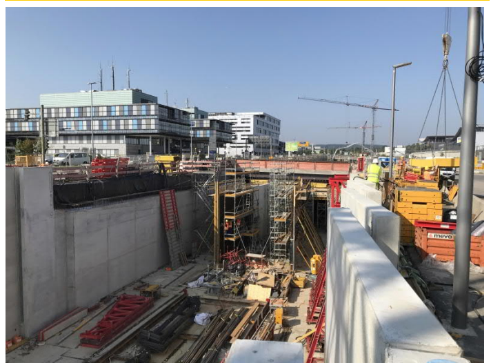
Herstellung Betriebsräume Haltestelle Flughafen/Messe
