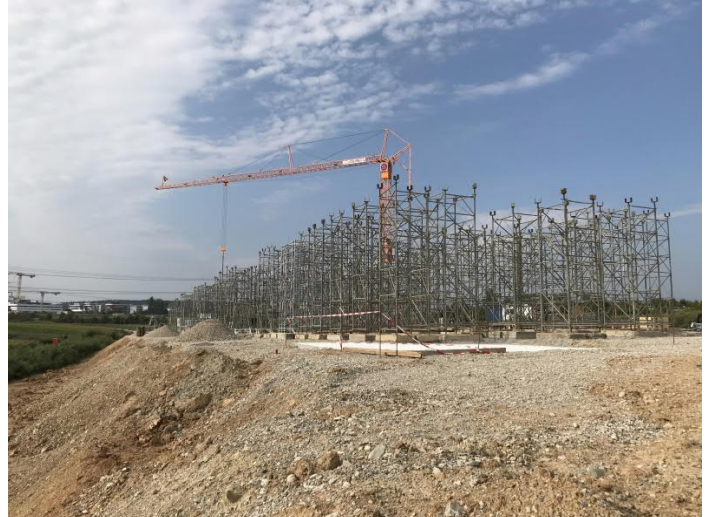
Vorbereitung Traggerüst auf Montagedamm für Brücke A8
