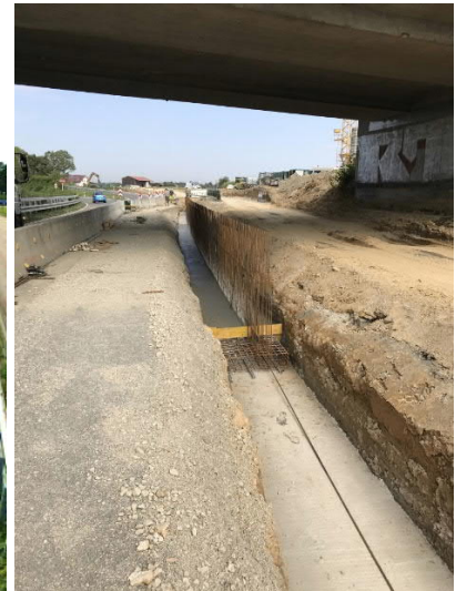
Herstellung Stützwand Unterführung L1192
