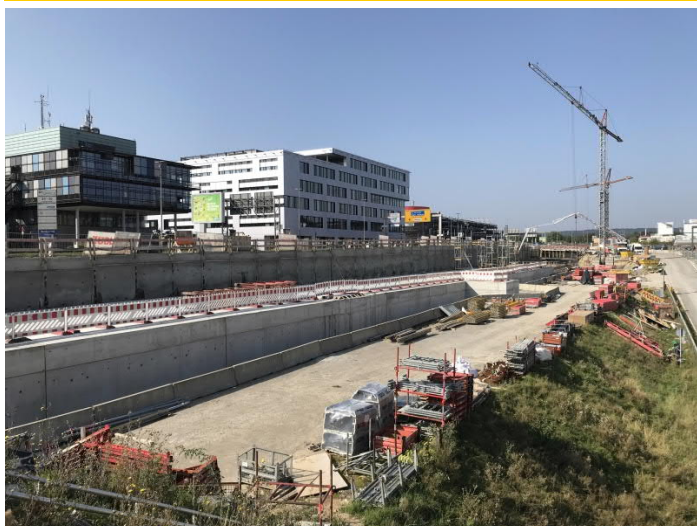
Fertiggestellter Tunnelabschnitt Blickrichtung Echterdingen
