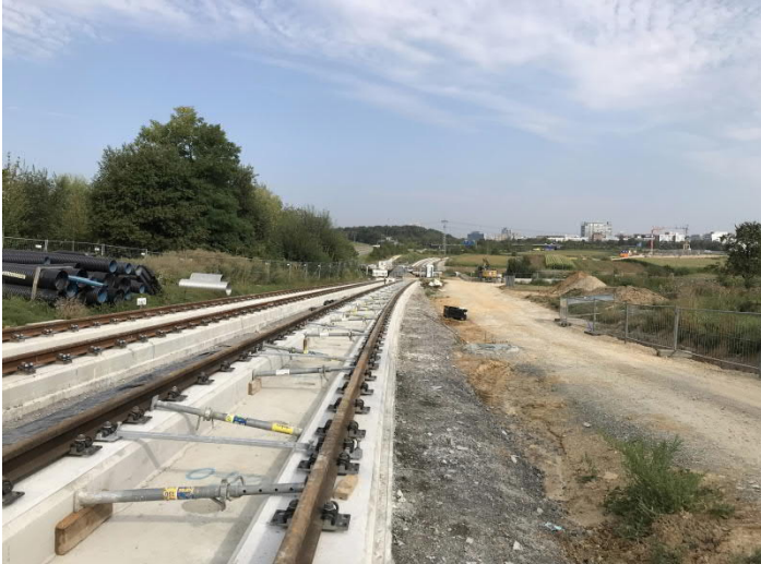
Gleisbau im Bereich Erlengraben und Streitgraben
