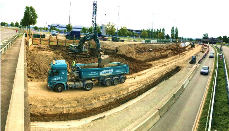
Baugrube Betriebsgebäude Unterwerk Messe u. Stützwand
