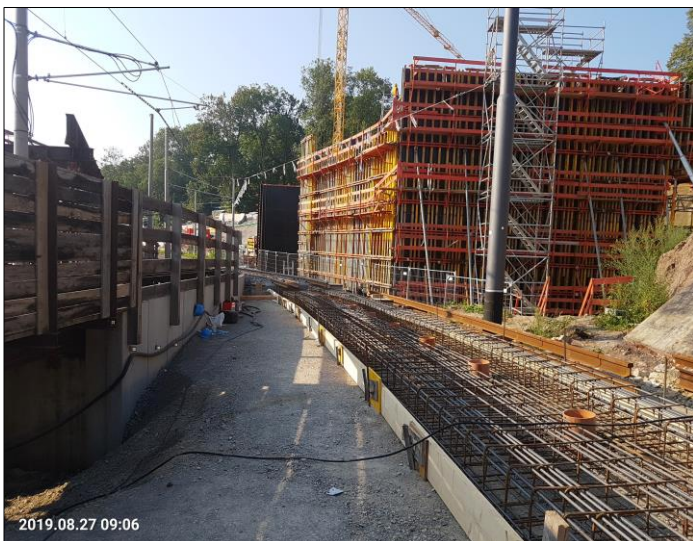
Bild 3: Stadteinwärtsgleis neu vor künftigem Widerlager
