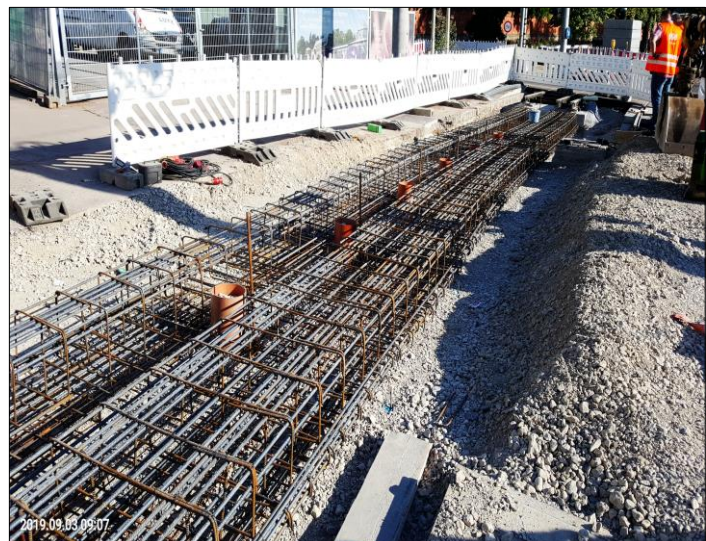
Bild 4: Bewehrung für feste Fahrbahn (Rasengleis)
