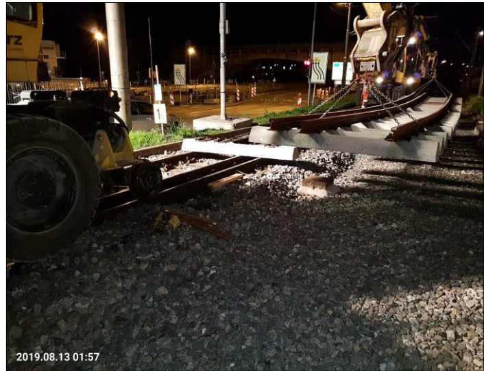
Bild 2: Nächtlicher Einbau von Gleisrahmen
