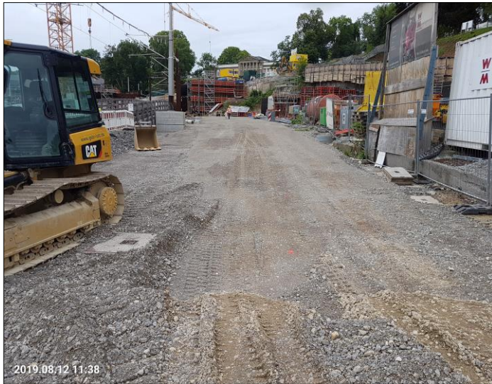
Bild 1: Vorbereitung des Gleisunterbaus
