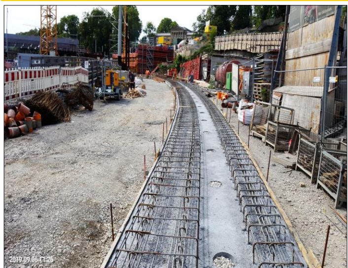
Bild 6: Betonplatte feste Fahrbahn betoniert
