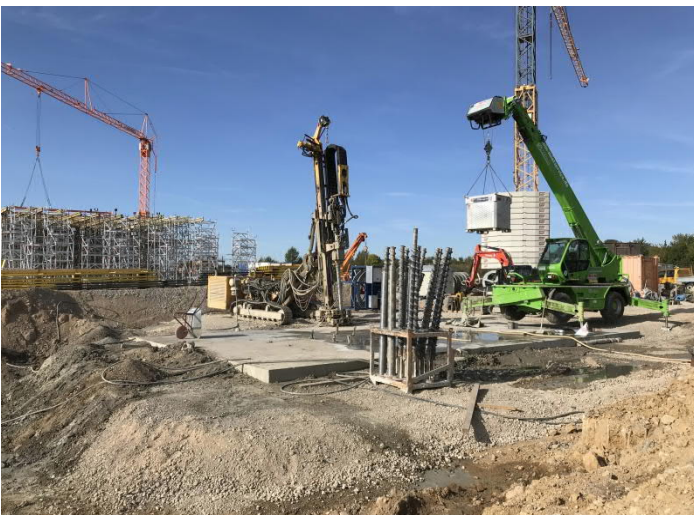
Traggerüst u. Ankerarbeiten am Widerlager Süd Brücke A8
