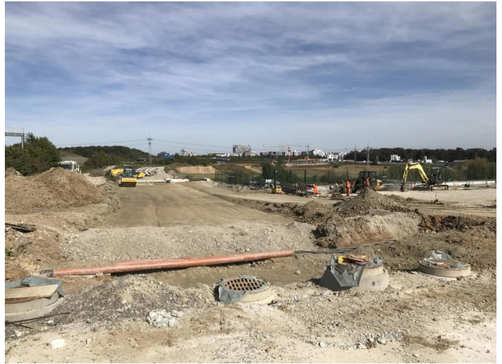
"Lückenschluss" Gleisbau an der Brücke Erlengraben
