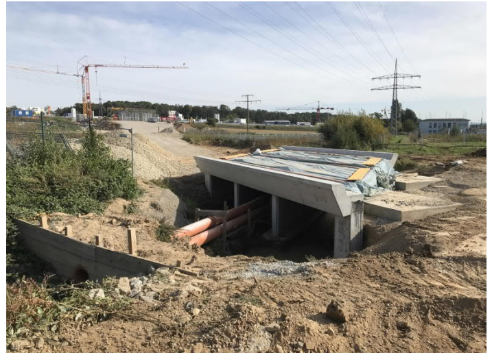
Brücke Streitgraben (Traggerüst Brücke A8 im Hintergrund)
