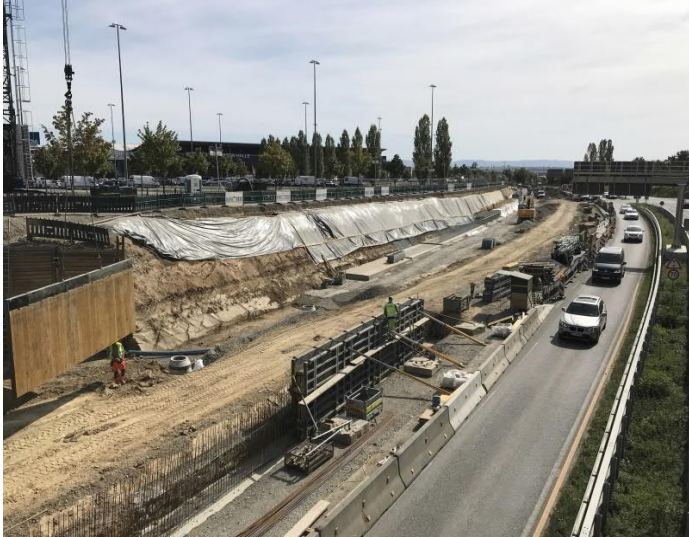
Steingabionenwand entlang Parkplatzanlage P26 Messe
