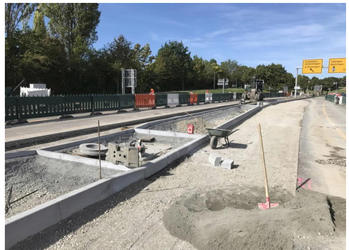
Umbau des Mittelstreifens der Flughafenstraße im Bereich P26
