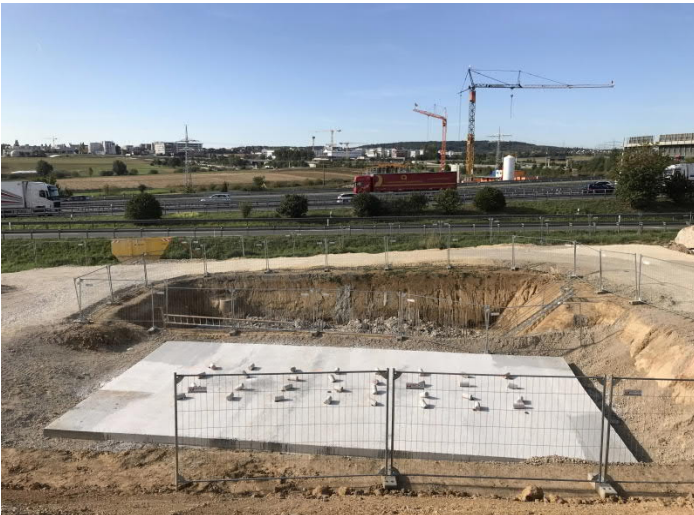
Brücke A8 Widerlager Nord i. R. Autobahn/Echterdingen
