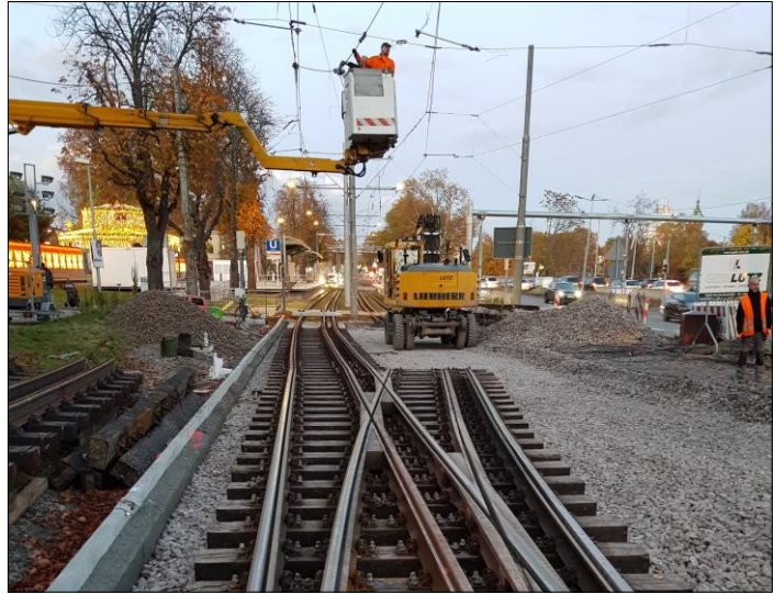
Bild 2: Anpassung der Fahrleitungsanlage
