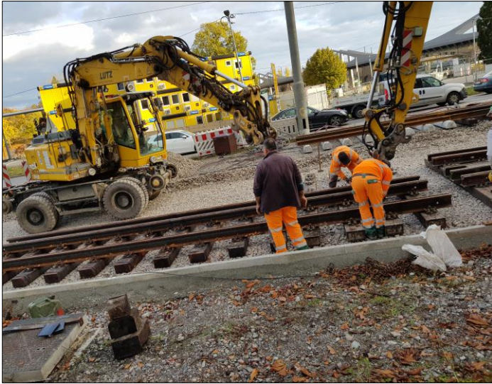
Bild 1: Einbau von Gleisrahmen
