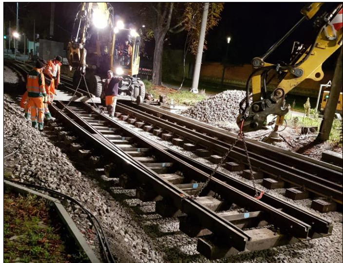
Bild 4: Einbau von Gleisrahmen
