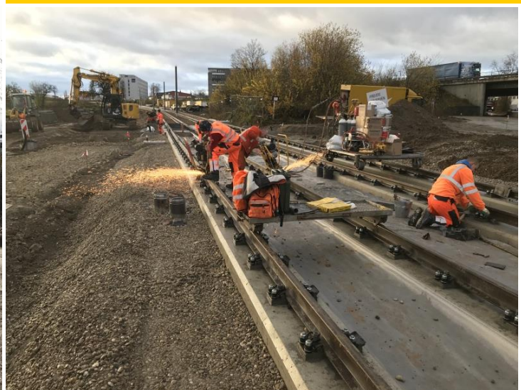
Nachbereitung Schienenschweißen am Bahnübergang Erlengraben
