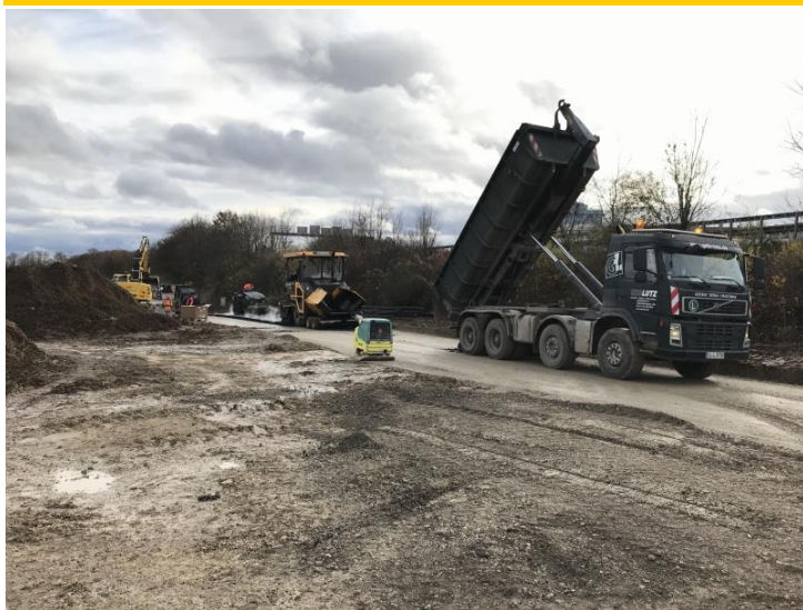
Feldwegbau östlich der Unterführung Stadionstraße
