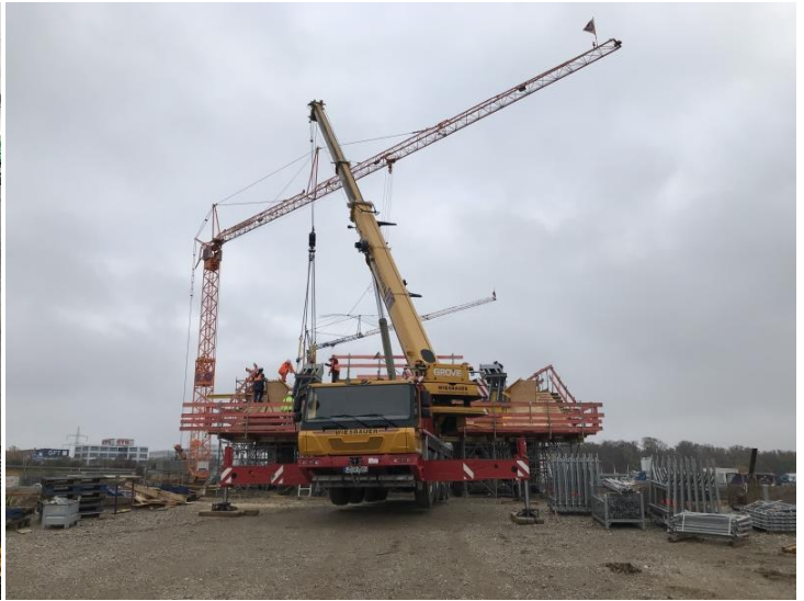
Einhub der Kämpfeinbauteile in die Schalung der Brücke A8
