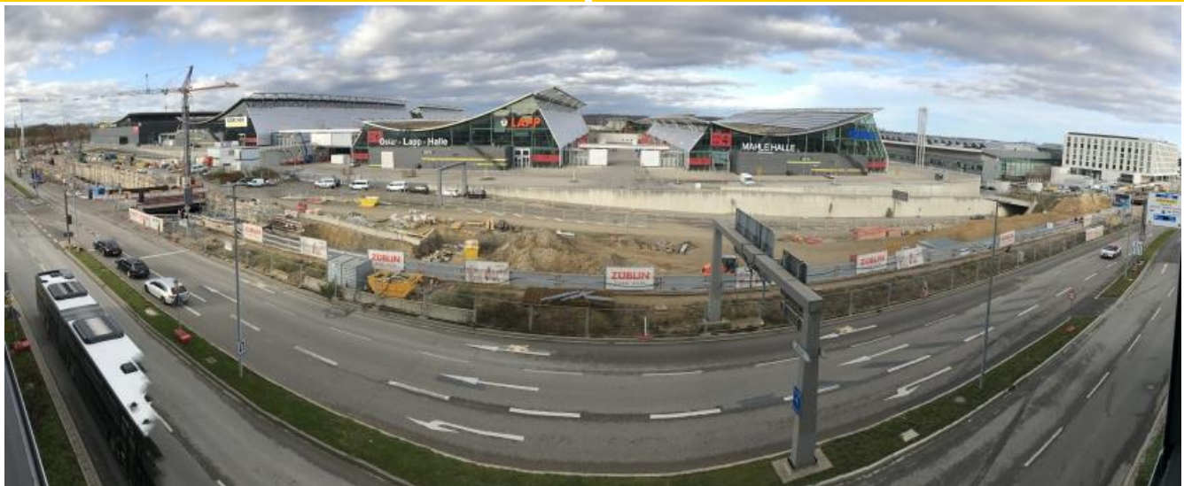
Tunnelbaustelle Blickrichtung West
