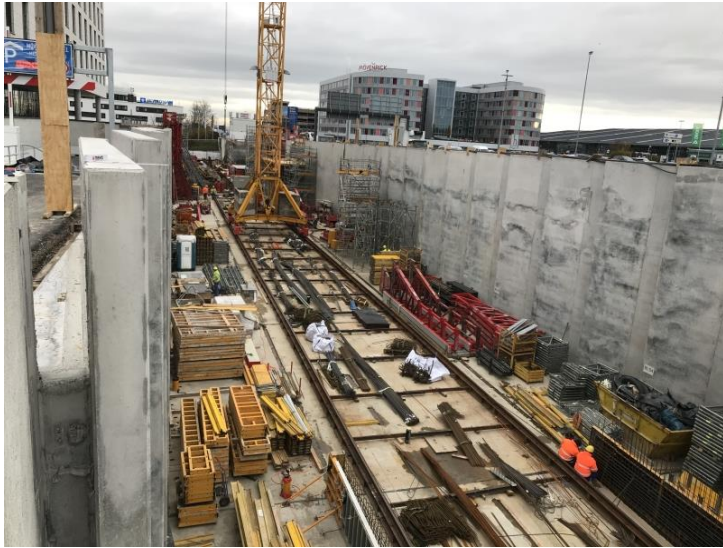
Rohbauarbeiten an der Haltestelle Flughafen/Messe
