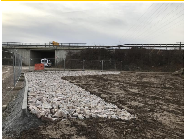
Überlaufbauwerk für den Hochwasserschutz am Streitgraben
