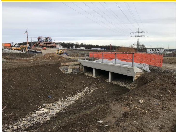
Streitgrabenbrücke und Brücke über die A8 (Hintergrund)
