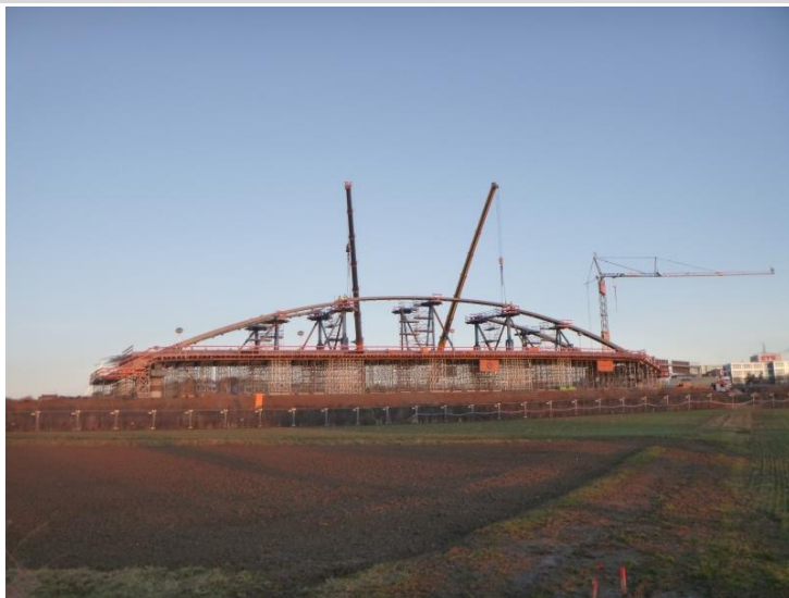
Ausrichten und Vormontage der Bogensegmente Brücke A8
