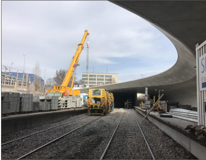
Stopfarbeiten im Bereich d. neuen Haltestelle
