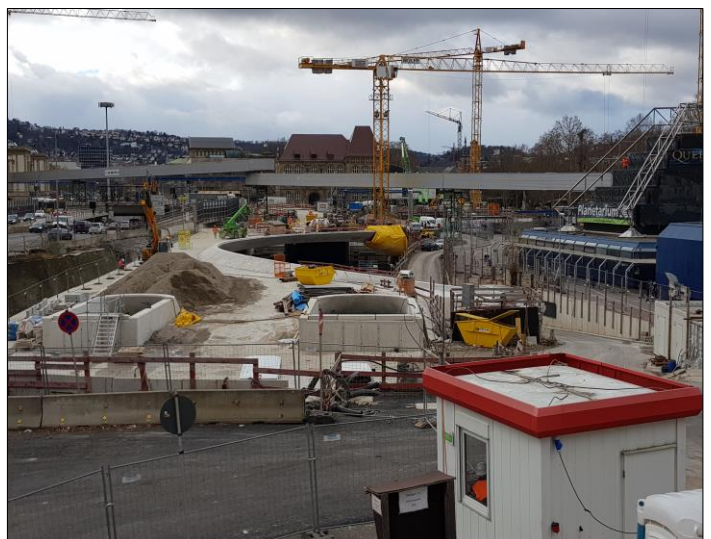
Blick auf die Baustelle im Bereich des Planetariums
