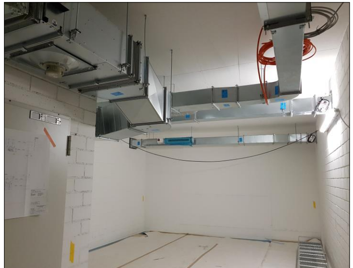
Herstellung d. Lüftungsanlage in den Betriebsräumen
