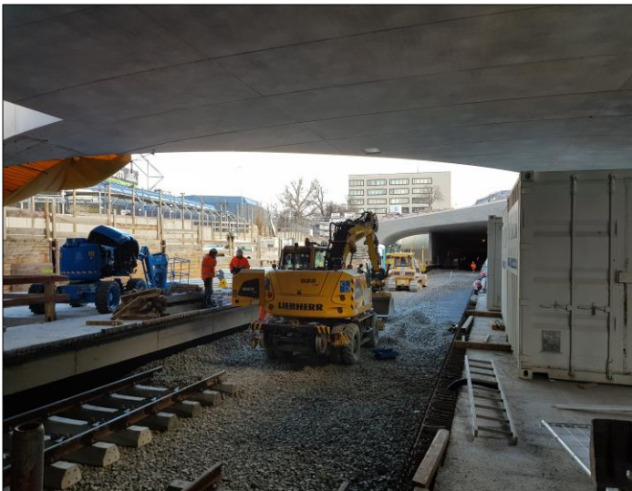
Gleisbauarbeiten im Bereich d. neuen Haltestelle
