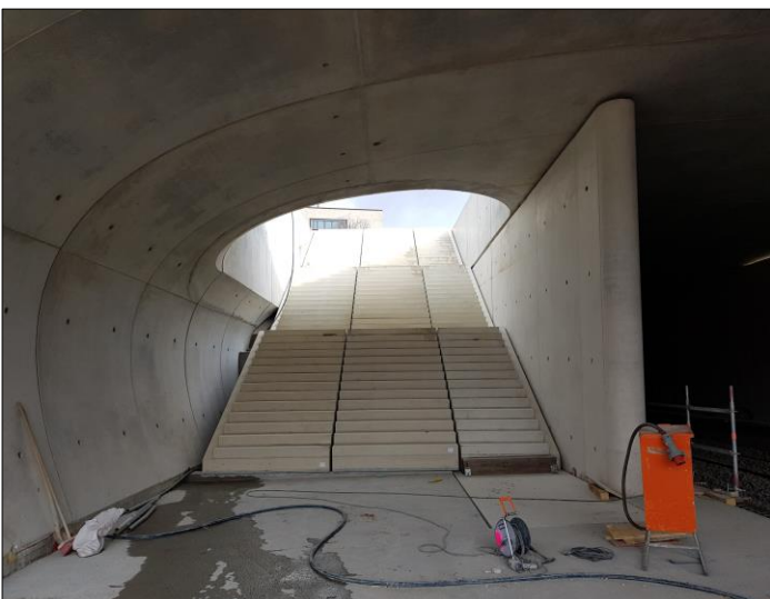
Hergestellte Treppe (Rohbau)
