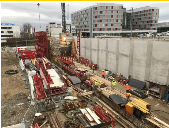
Rohbau Endhaltestelle Bereich Messepiazza Ost
