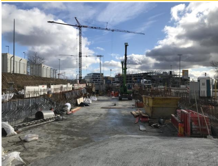
Rohbau Tunnelrampe Einfahrtbereich
