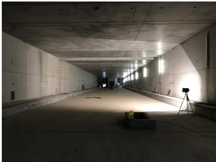
Fertiggestellter Tunnelrohbau; Blick i. R. Endhaltestelle
