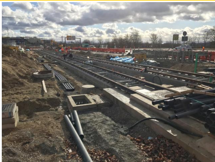
Gleisbau im Bereich Haltestelle Messe West
