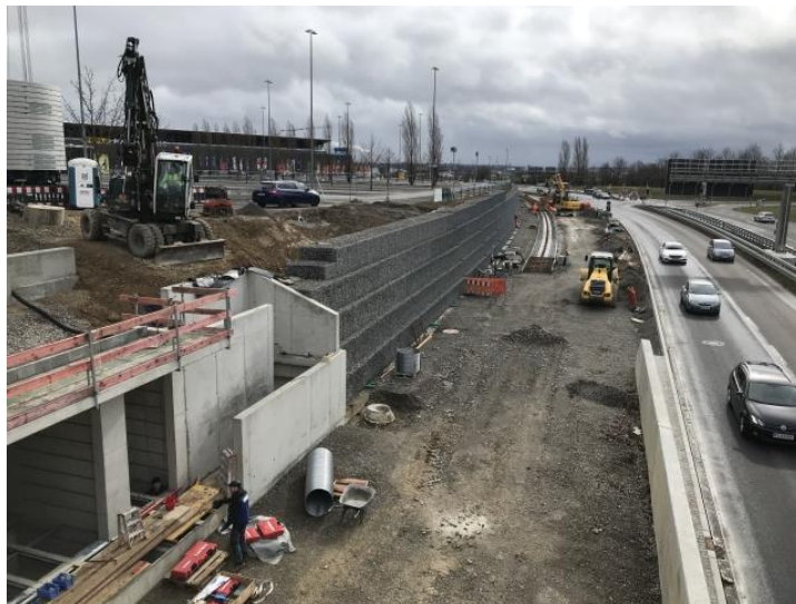
Links: Betriebsgebäude Messe West; Rechts: Gleisbau
