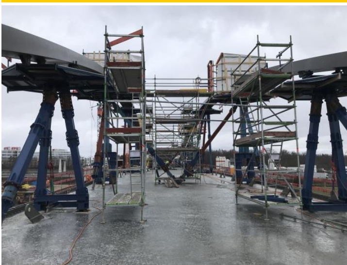
Schweißen der Netzkorbögen Brücke A8
