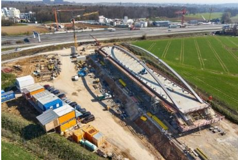
Hauptfeld der Brücke A8 ist bereit für das Einfahren über die Autobahn
