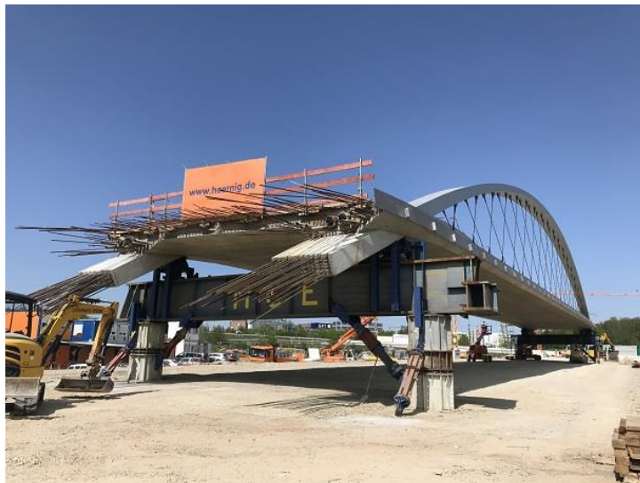
Freigestelltes Hauptfeld Brücke A8
