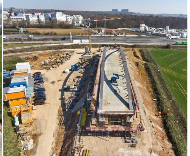
Hauptfeld der Brücke A8 ist bereit für das Einfahren über die Autobahn
