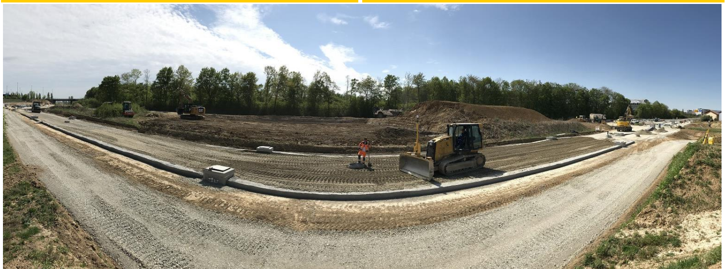
Herstellung Streckenunterbau und Bahnsteig im Bereich der neuen Haltestelle Stadionstraße
