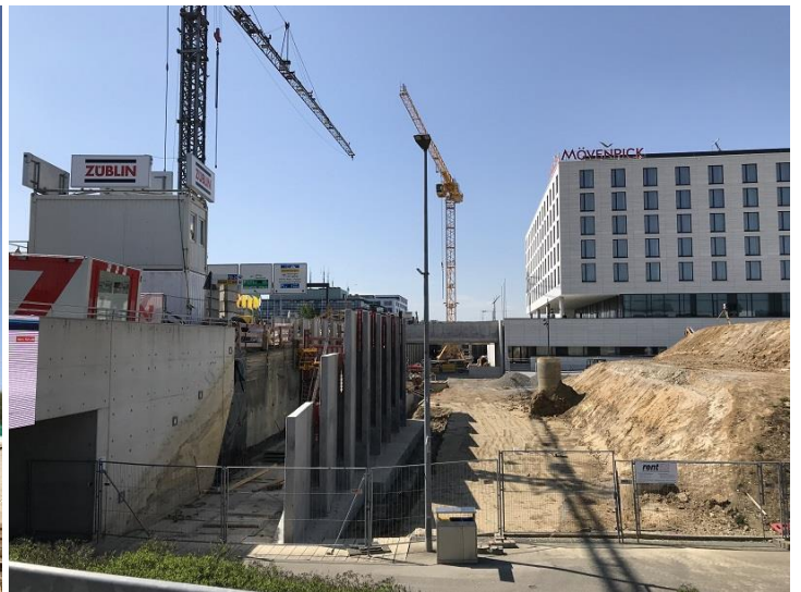
Rohbau Haltestellenzugang Messeplatz Ost
