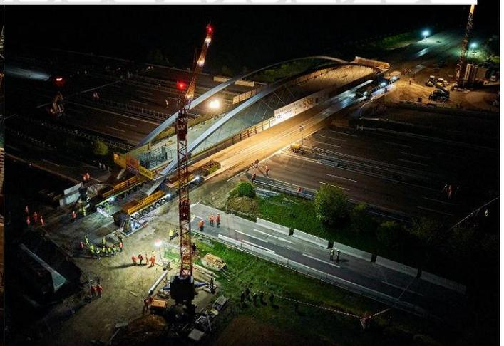
Brücke wird eingefahren und auf Hilfsstützen abgesetzt
