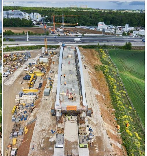
Hauptfeld der Brücke A8 ist bereit für das Einfahren über die Autobahn
