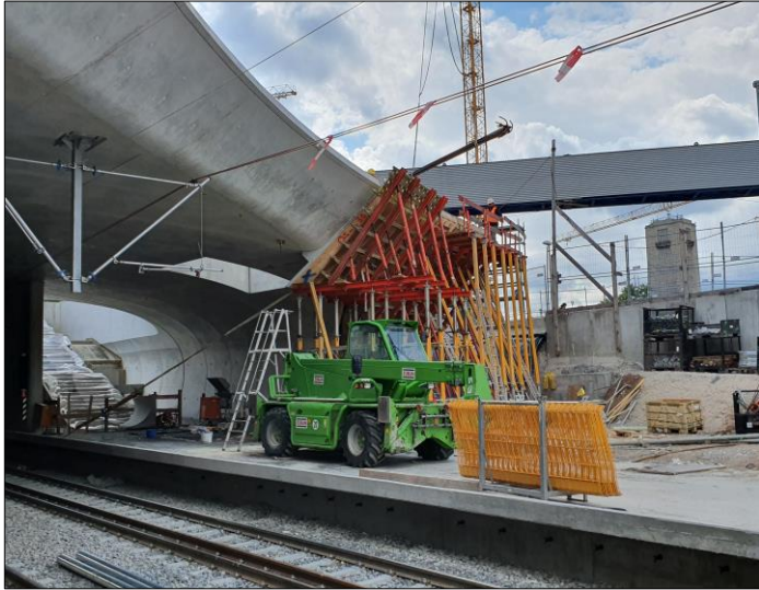
Herstellung des letzten Teilstücks d. Öffnungsschale
