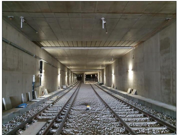
Hergestellter Tunnel in Richtung Neckartor
