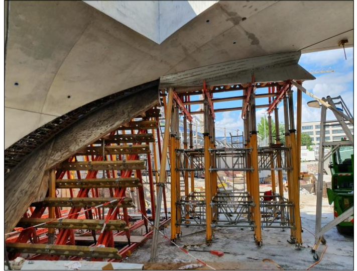
Herstellung des letzten Teilstücks d. Öffnungsschale
