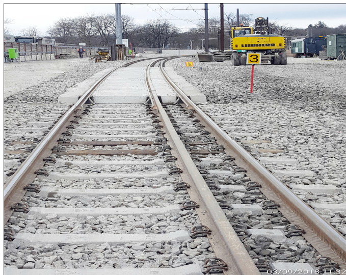
PG: Betonplatte für die künftige Gleisüberfahrt der B10
