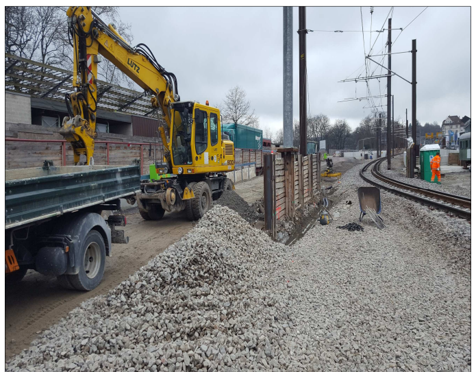
PG: Baustellenbetrieb Gleisbaugewerk
