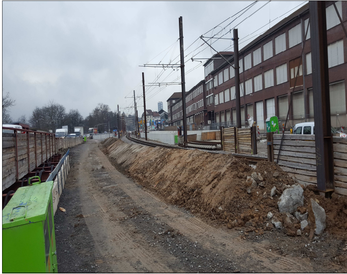
PG: Baugrubenverfüllung auf neuem Tunnelbauwerk
