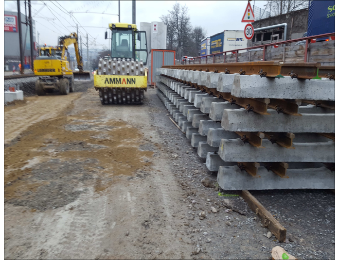
PG: Baugrundvorbereitung für Gleisbau
