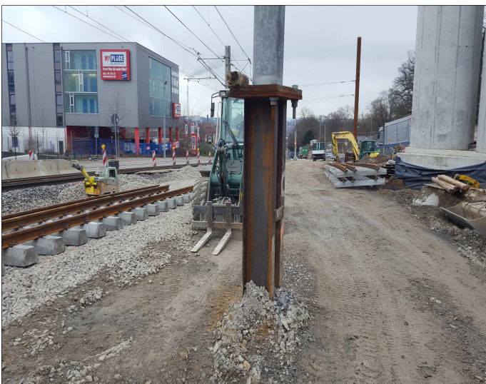
PG: Temporärer Fahrleitungsmast (ehem. Verbasträger)
