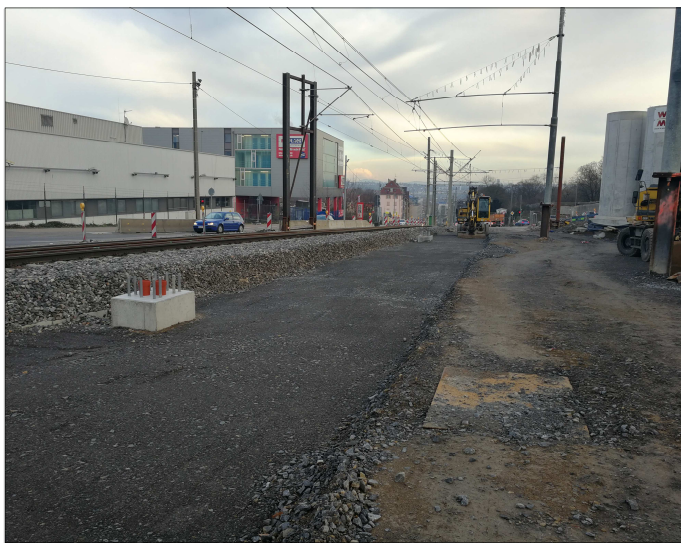
PG: Für Gleisbau vorbereiteter Untergrund
