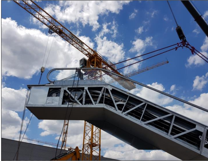
Anlieferung u. Einbau der Fahrtreppen
