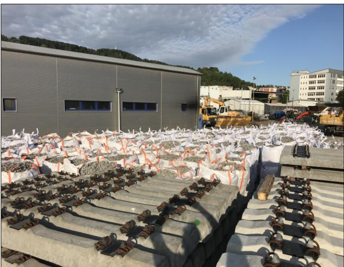
Vorbereitungsarbeiten Gleisbau für Umschluss
