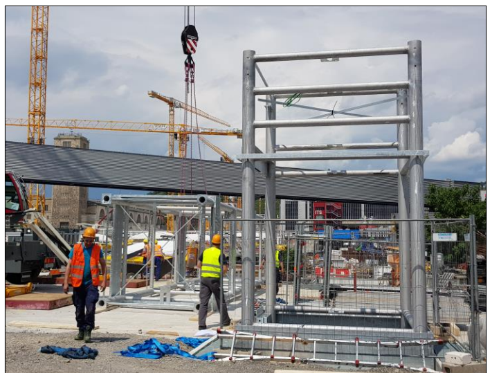
Montage Aufzugsgerüst
