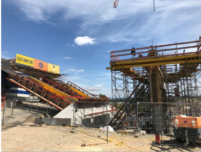
Brücke A8: Schalung und Bewehrungsarbeiten am Widerlager Süd
