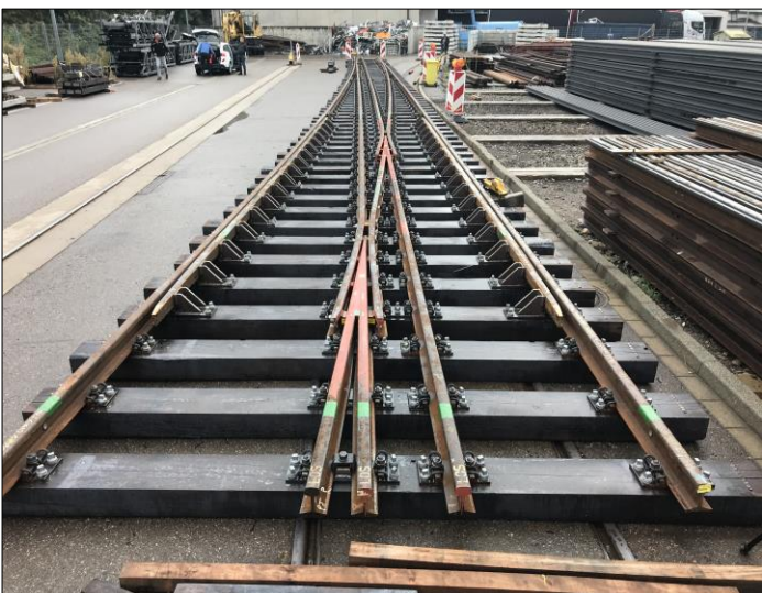
Vorbereitung der Weiche für den Umschluss
