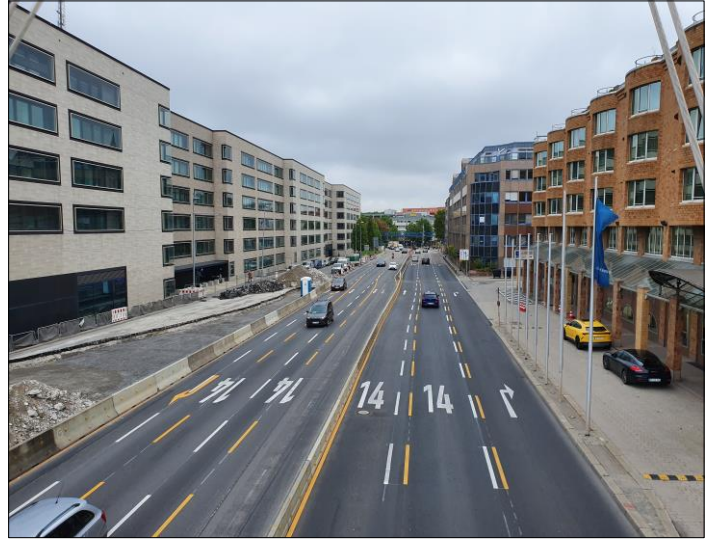
Hergestellte Verkehrstufe im Bereich des Innenministeriums
