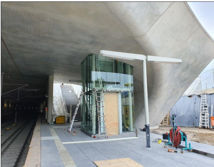
Verglasung des Aufzugsschachts am Seitenbahnsteig
