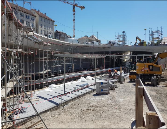
Herstellung des Geländers oberhalb des Schalendachs
