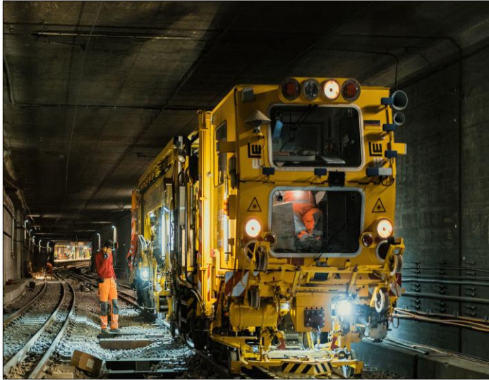
Stopfarbeiten im Zuge des Umschlusses Bestand - Neubau
