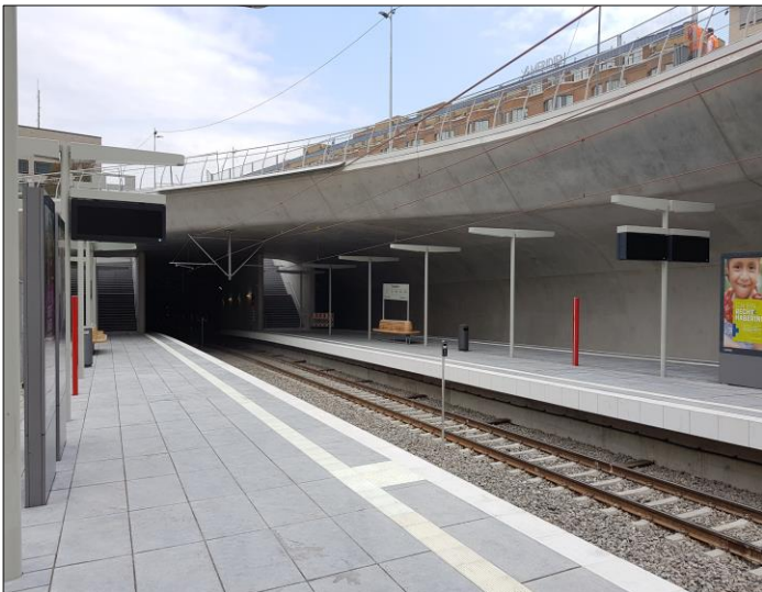
Blick auf den hergestellten Seiten- und Mittelbahnsteig
