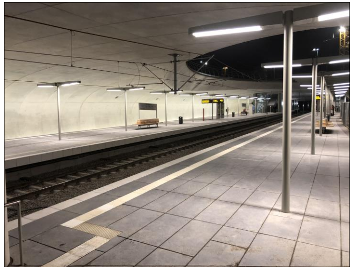
Blick auf den hergestellten Seiten- und Mittelbahnsteig
