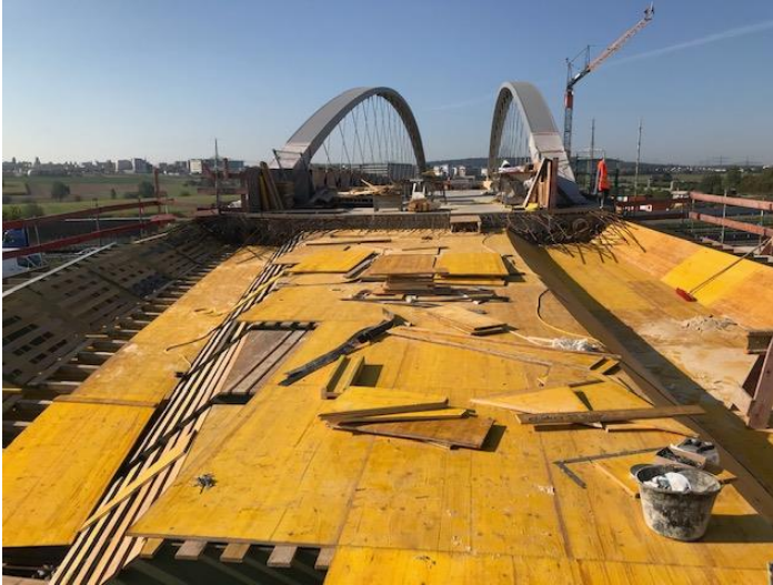
Brücke A8: Schalungsarbeiten am Seitenfeld Nord
