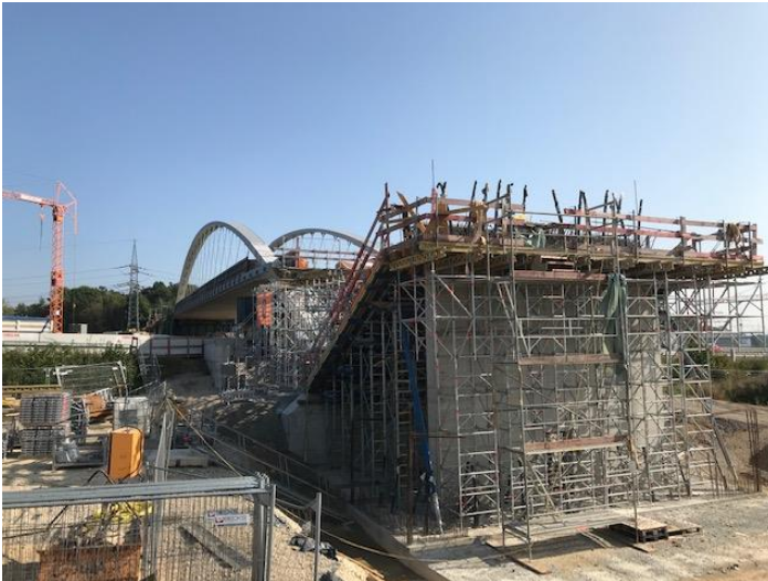
Brücke A8: Traggerüst für das Fahrbahndeck am Seitenfeld Süd
