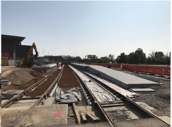
Haltestelle Messe West: Belagsarbeiten fertig; Begrünung Gleis
