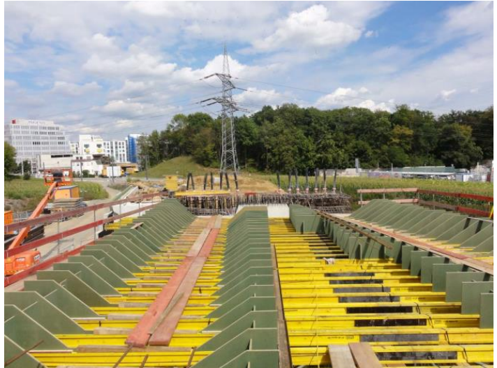
Brücke A8: Schalungsarbeiten am Seitenfeld Nord
