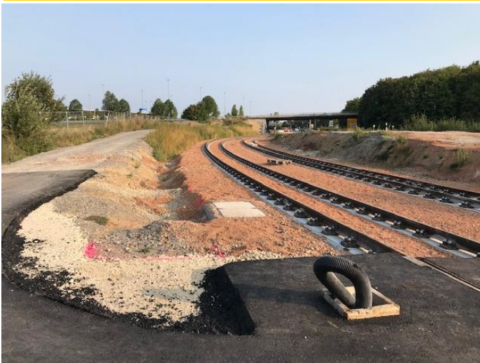
Blick in Richtung Landesmesse, Bahnübergang Plieninger Weg
