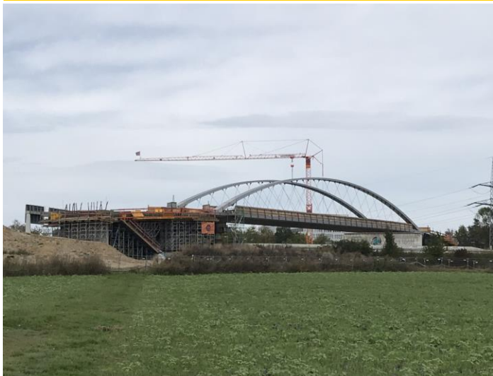
Brücke A8: Traggerüst für das Fahrbahndeck am Seitenfeld Süd
