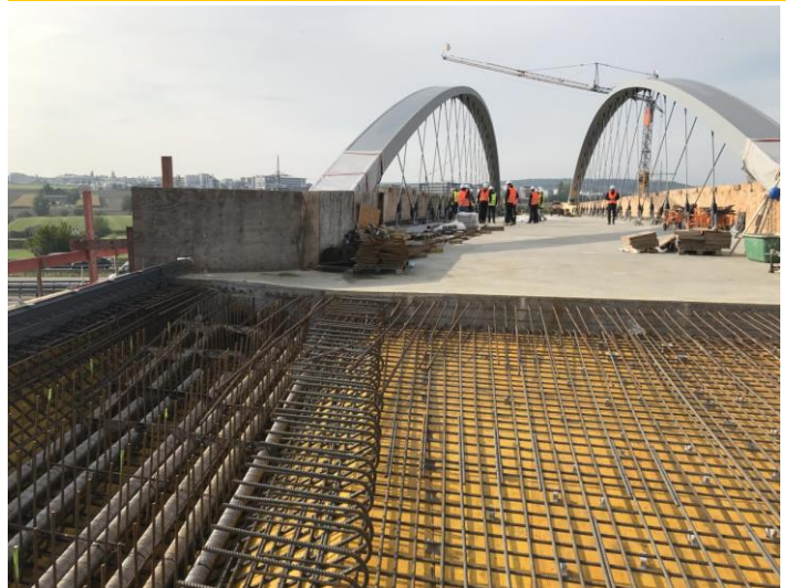
Brücke A8: Schalung+Bewehrung am Seitenfeld Nord
