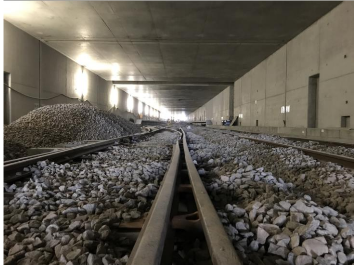
Gleisbau im Tunnel an der Flughafenstraße
