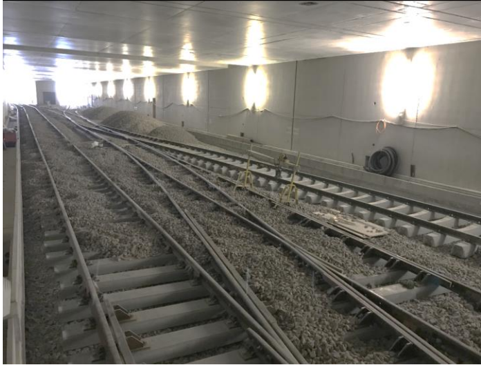
Gleisbau im Tunnel an der Flughafenstraße
