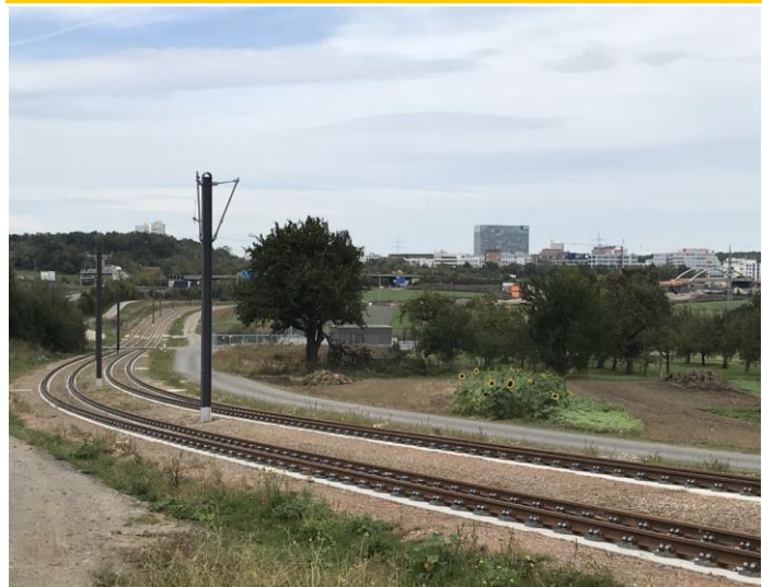
Blick in Richtung Stuttgart; Strecke und Brücke A8 (hinten rechts)
