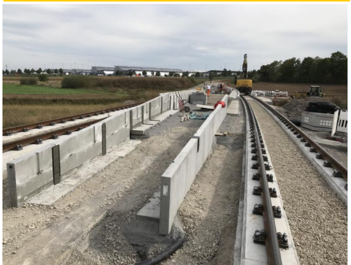
Herstellung Bahnsteig Haltestelle Stadionstraße
