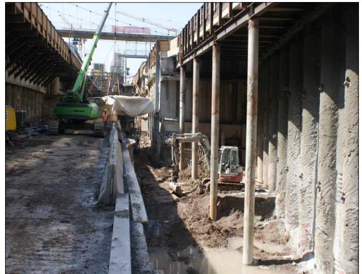
Bereich für den späteren Anschluss an den Bestandstunnel
