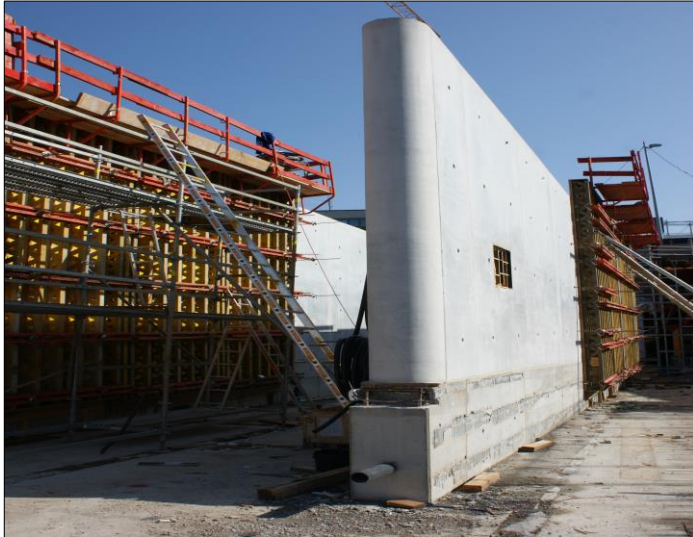
Herstellung der Innenwände (zum Teil in Weißbeton)
