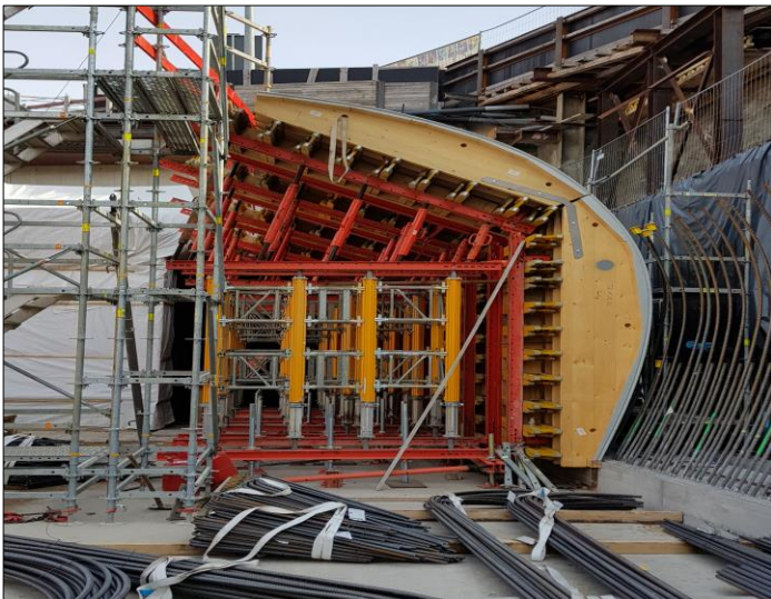
Schalung für das Betonieren des Schalendaches
