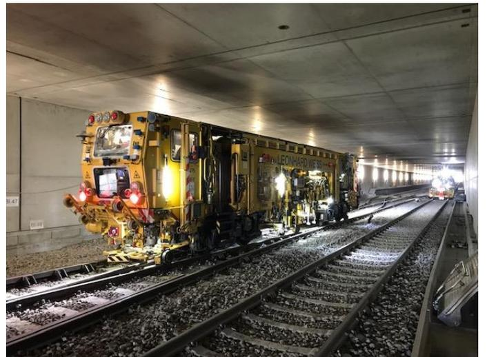
Stopfarbeiten am Schottergleis im Tunnel
