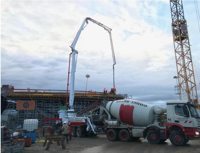
Betoneinbau der Seitenfelder an der Brücke A8
