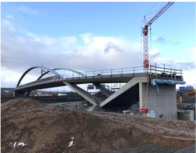
Tragwerk Stadtbahnbrücke A8 steht erstmals "selbstständig"
