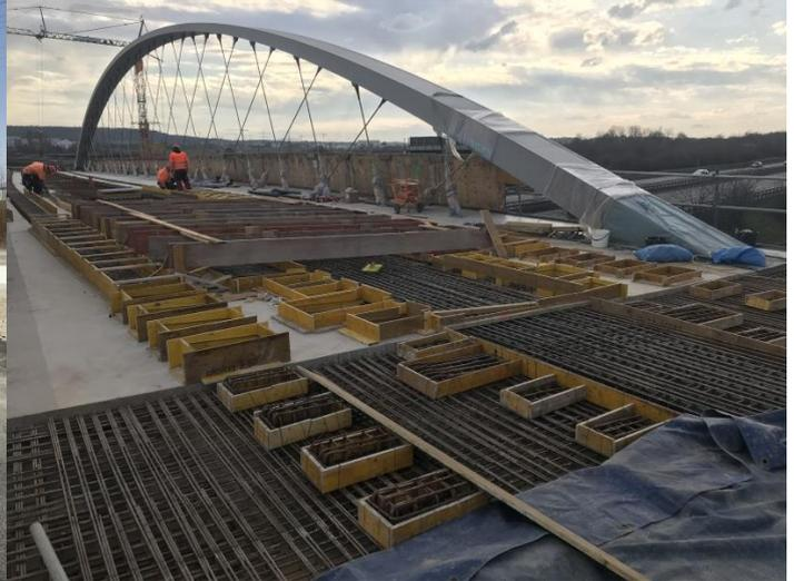
Beton für die Schienen auf der Brücke A8 nimmt Gestalt an
