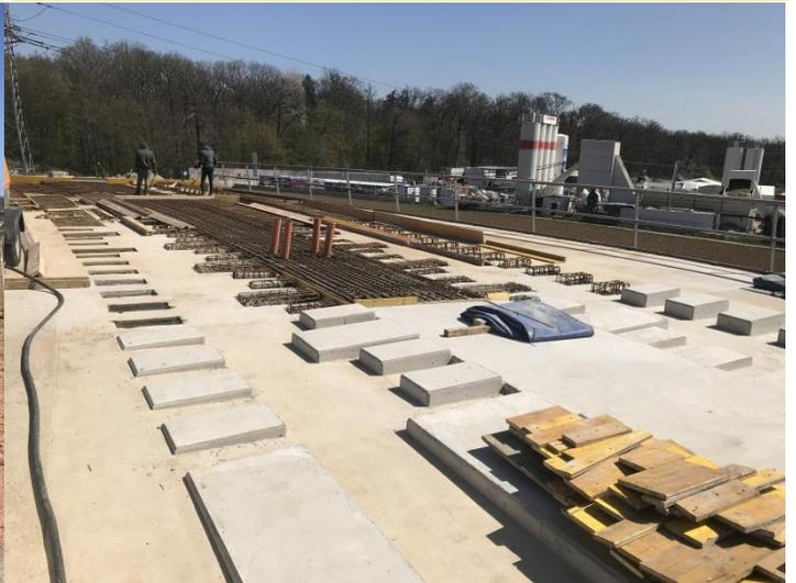
Gleisbau Feste Fahrbahn auf der Brücke A8
