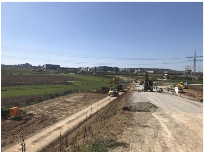
Feldwegebau u. Vorbereit. Gleisbau Feste Fahrbahn am Erddamm Süd
