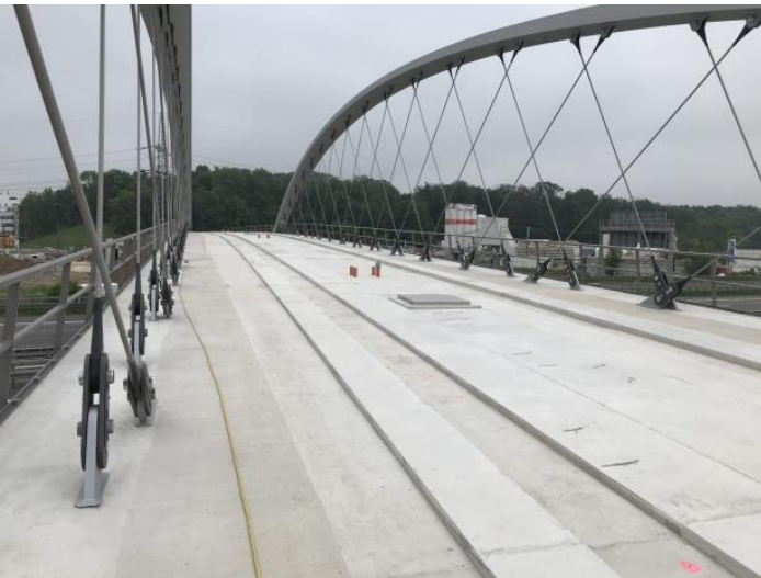
Fertiggestelltes Brückenbauwerk über die A8 inkl. Gleisbeton
