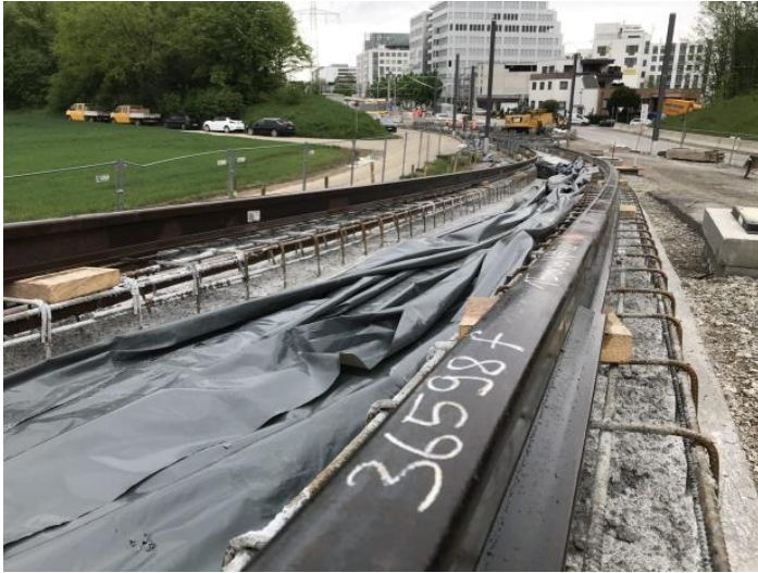
Gleisbauarbeiten Feste Fahrbahn am Erddamm Nord Brücke A8
