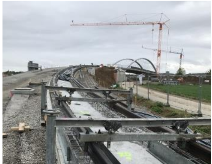
Gleisbauarbeiten Feste Fahrbahn am Erddamm Nord Brücke A8
