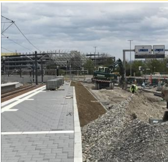
Straßenbauarbeiten im Bereich der Haltestelle Messe West
