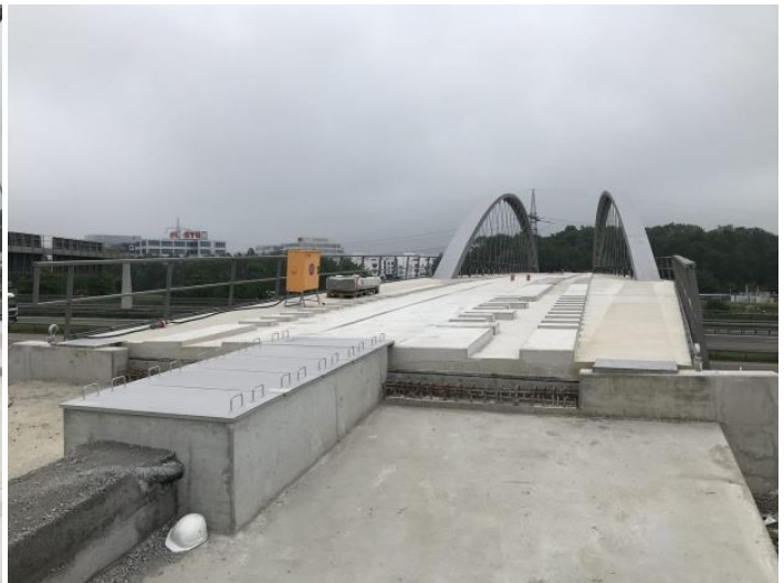
Fertiggestelltes Brückenbauwerk über die A8 inkl. Gleisbeton
