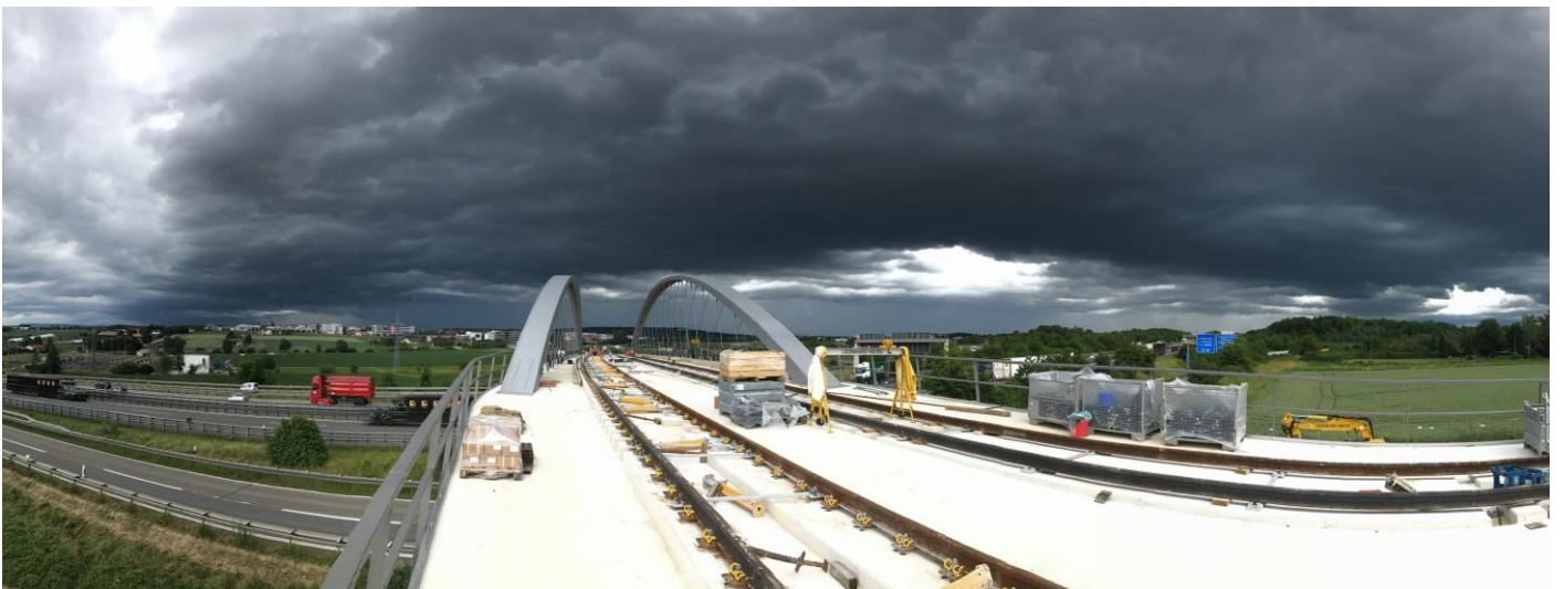
Die Gleise werden auf die Brücke A8 verlegt/montiert
