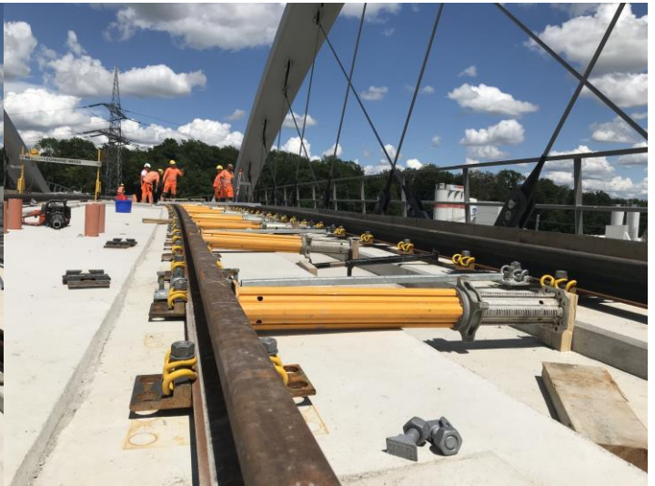
Die Gleise werden auf die Brücke A8 verlegt/montiert
