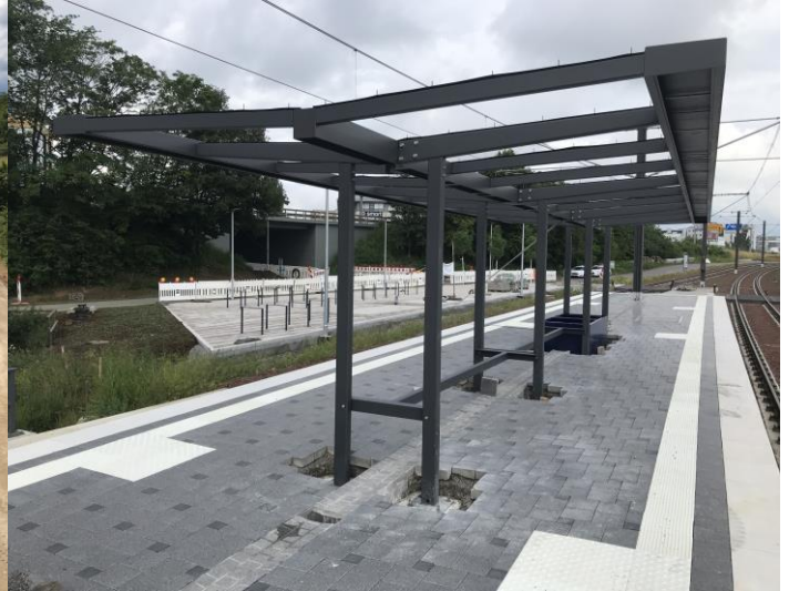
Stahlkonstruktion der Wartehallen Hst. Stadionstraße sind montiert
