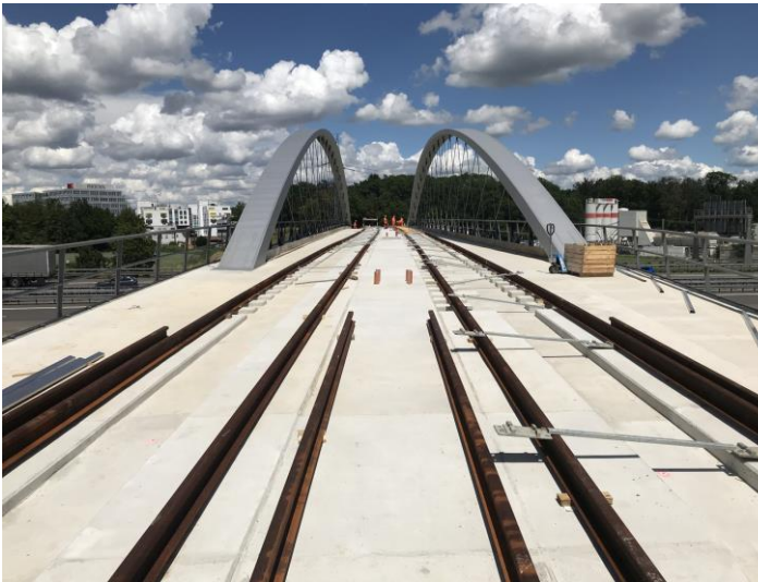
Die Gleise werden auf die Brücke A8 verlegt/montiert
