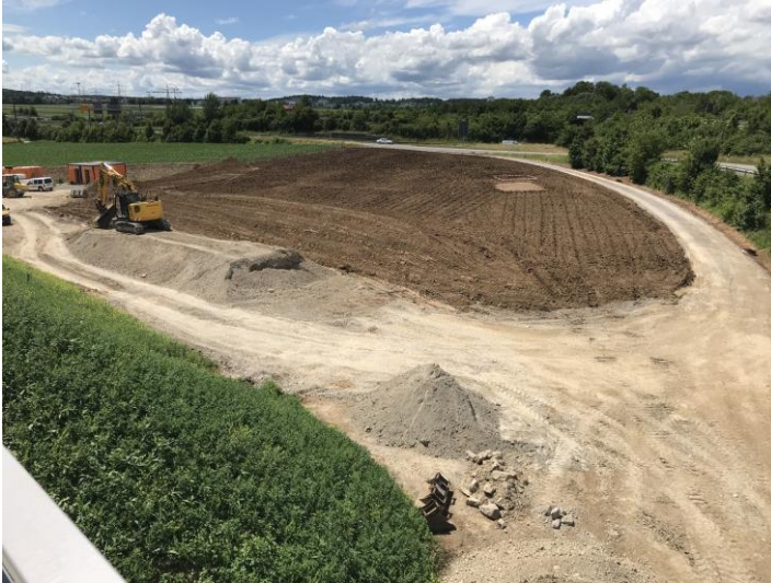
Rekultivierung der Ackerflächen an der Baustelle Brücke A8
