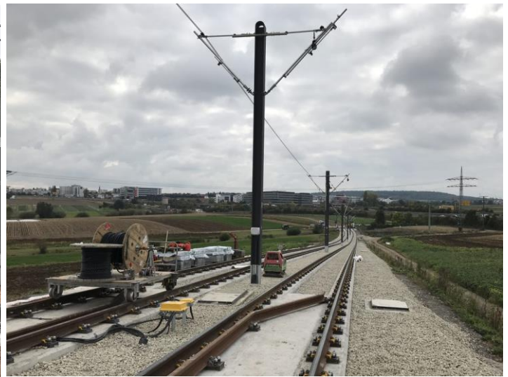
Fertiggestellte Gleisanlage vor Begrünung
