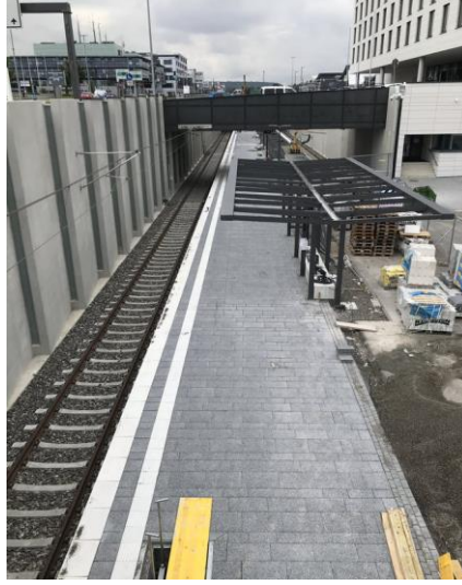
Blockstufen u. Belagsarbeiten an der Endhaltestelle Flughafen/Messe
