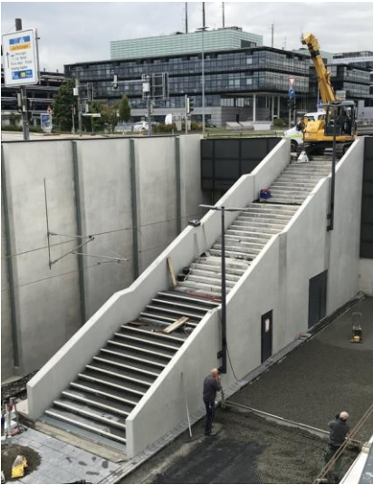
Blockstufen u. Belagsarbeiten an der Endhaltestelle Flughafen/Messe
