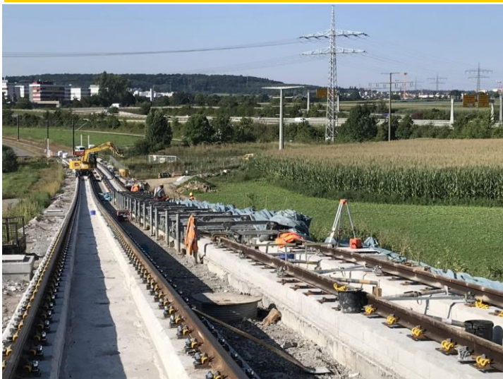
Die letzten 300m Streckengleis werden gebaut
