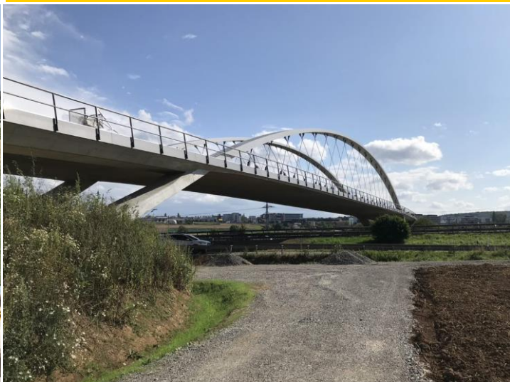
Fertiggestellte Brücke über die A8
