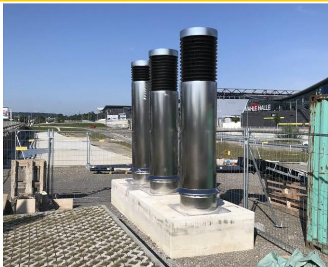
Lüftungskamine der Betriebsräume Haltestelle Flughafen/Messe
