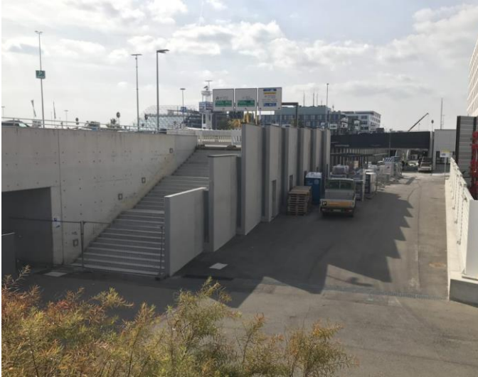
Belagsarbeiten an den Treppen- und Bahnsteiganlagen
