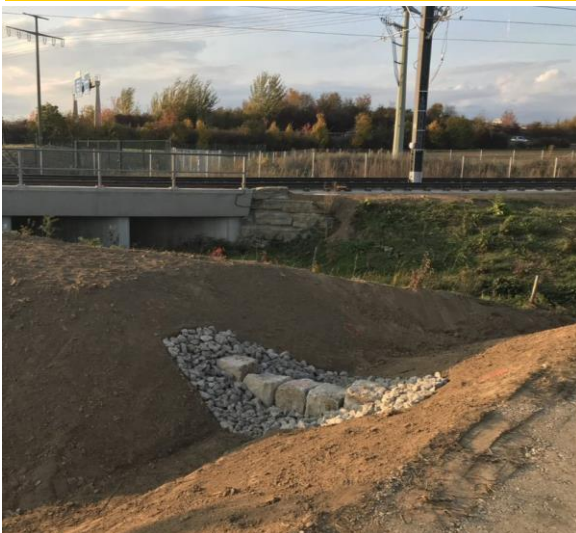
Fertigstellung Auslauf Regenrückhaltebecken Streitgraben Süd
