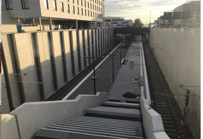
Belagsarbeiten an den Treppen- und Bahnsteiganlagen
