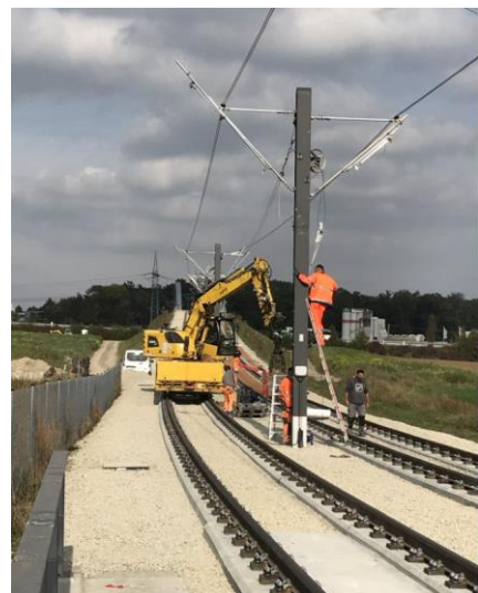
Arbeiten an der Fahrleitungsanlage
