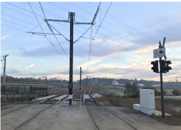
Fertiggestellte Gleisanlage in Richtung Brücke A8
