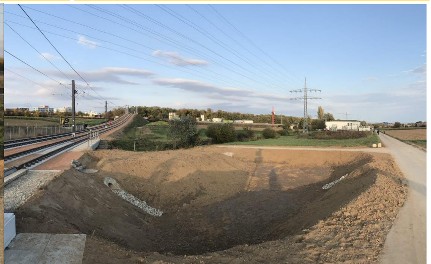
Fertigstellung Regenrückhaltebecken Streitgraben Süd
