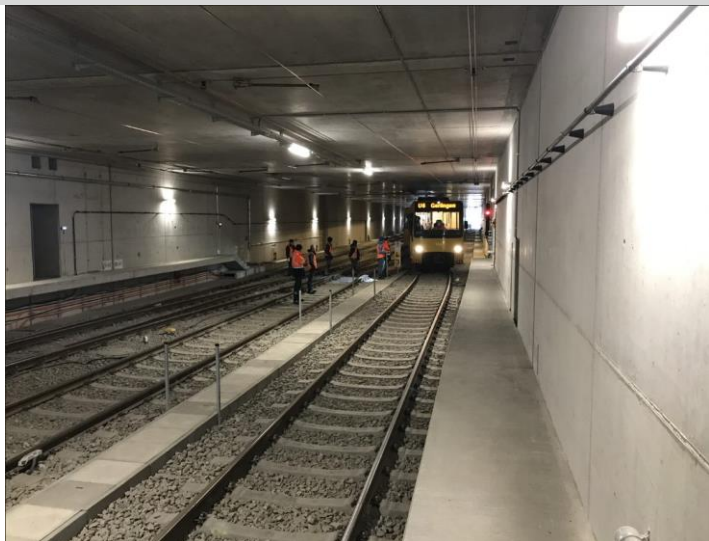
Überprüfung Fahrzeugprofil auf dem Bereitstellungsgleis im Tunnel
