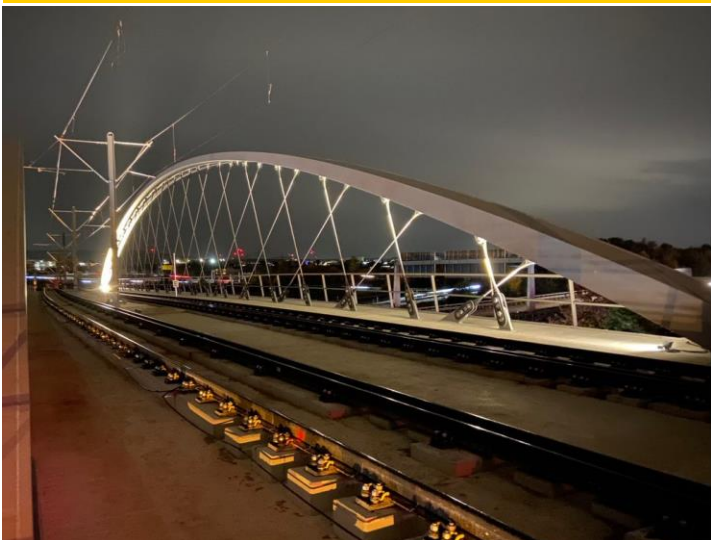
Die Netzwerkbögen der Brücke über die A8 werden illuminiert
