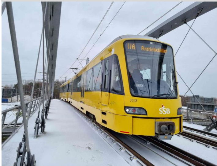
Testfahrt auf der Brücke über die A8
