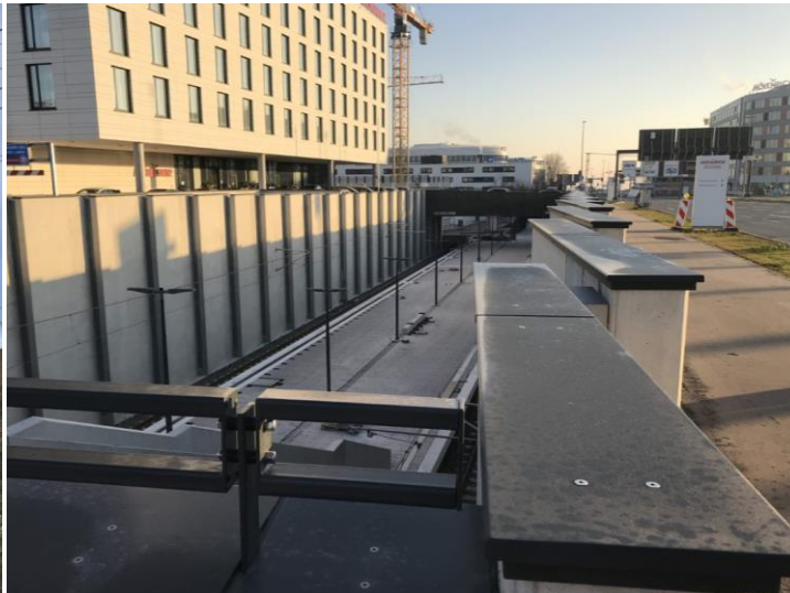
Arbeiten an der Fahrleitungsanlage
