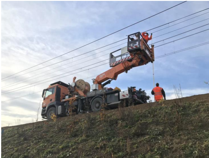
Feineinstellung der Fahrleitung
