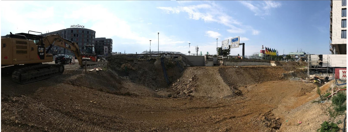
Baufeld vorbereiten im Bereich Endhaltestelle Flughafen/Messe
