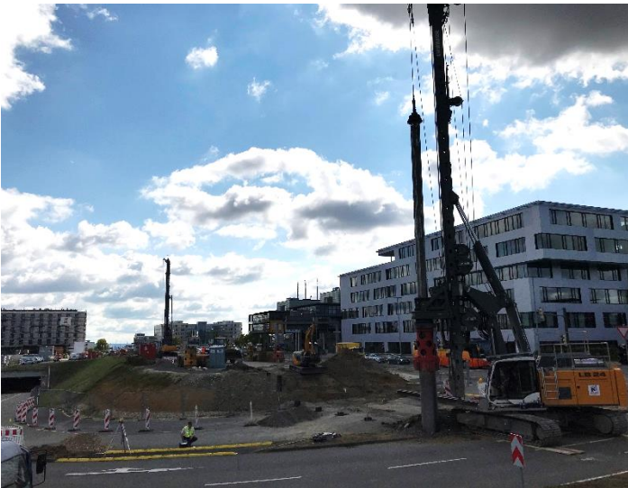
Bohrarbeiten u. Setzen der Verbauträger an der Tunnelbaustelle
