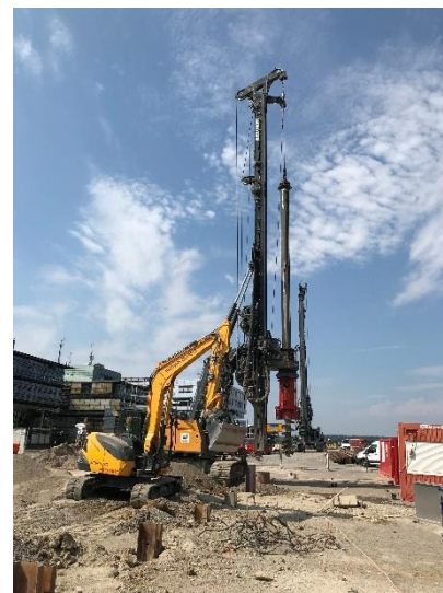
Bohrarbeiten u. Setzen der Verbauträger an der Tunnelbaustelle
