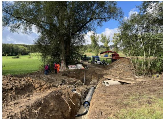
*Sicherungsarbeiten an der neuen Trinkwasserleitung*
