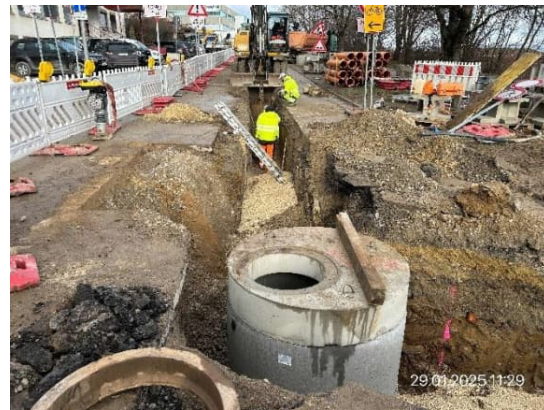
Kanalbauarbeiten in der Mercedesstraße
