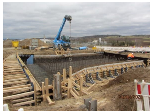
Der Deckel in der Mercedesstraße wird geschalt und bewehrt.
