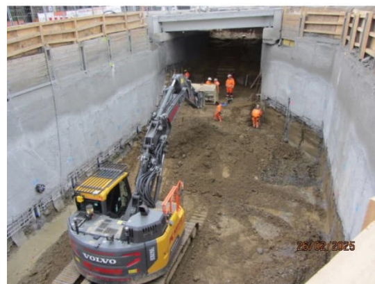
Baugrube neben der Werkszufahrt wird ausgehoben. Im Hintergrund ist die Hilfsbrücke zu sehen.
