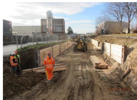
Baugrubensicherung im Osten des TKE Werksgeländes
