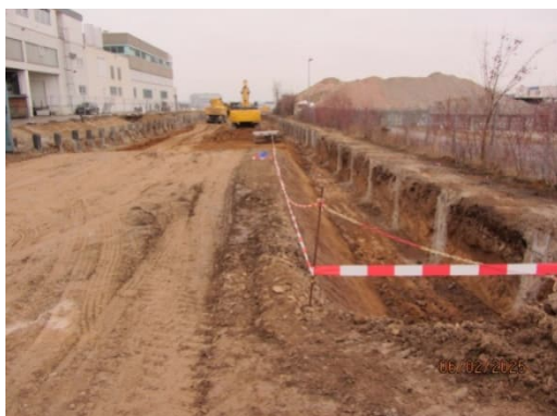
Östlich der Bahnhofstraße ist der Baugrubenaushub bereits gestartet.
