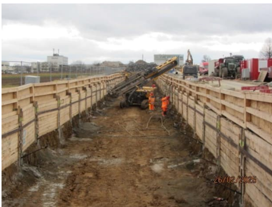
Rückverankerung der Baugrubenwände westlich des TKE Werksgeländes
