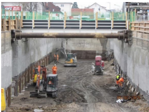
Baugrube auf Höhe der Gartenstraße, im Hintergrund ist die Stirnwand des Bestandstunnel freigelegt
