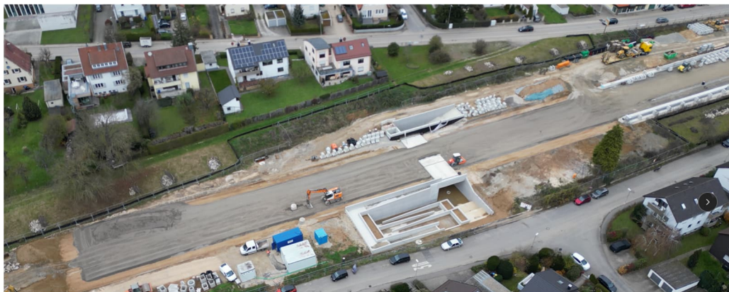
Bild oben: Die Bahnsteigkanten im neuen Bahnhofsareal sind gut erkennbar.
