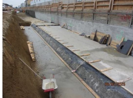
Dem Betonbau vorausseilend wird die Bauwerkssohle und Entwässerung vorbereitet
