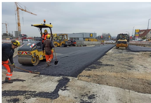
Der Deckel in der Kreuzung Nürtinger Straße / Karlstraße ist fertig und wird wieder als Straße genutzt
