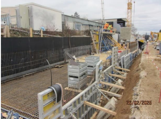
Das Trogbauwerk zwischen Industrie- und Wohngebiet wächst von Ost nach West
