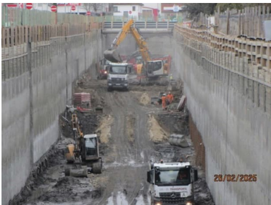
Baugrube entlang der Karlstraße fast auf Zielniveau
