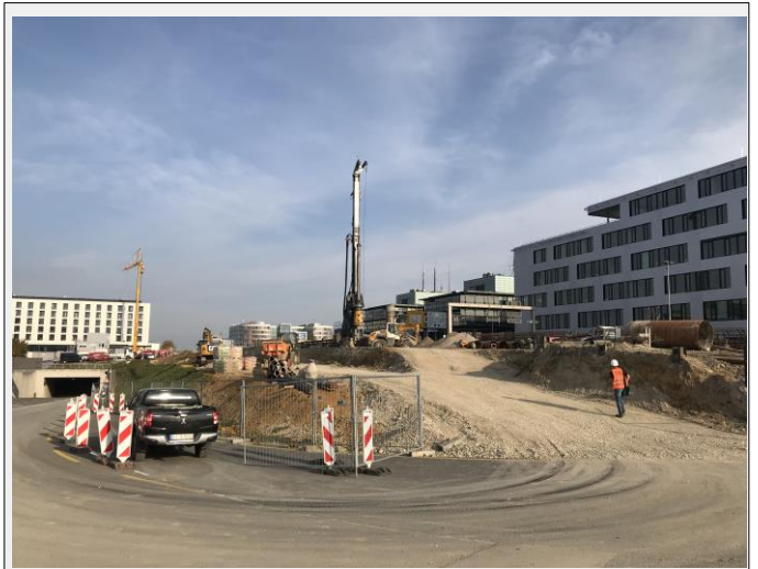
Bohrpfahlarbeiten am Tunnelabschnitt
