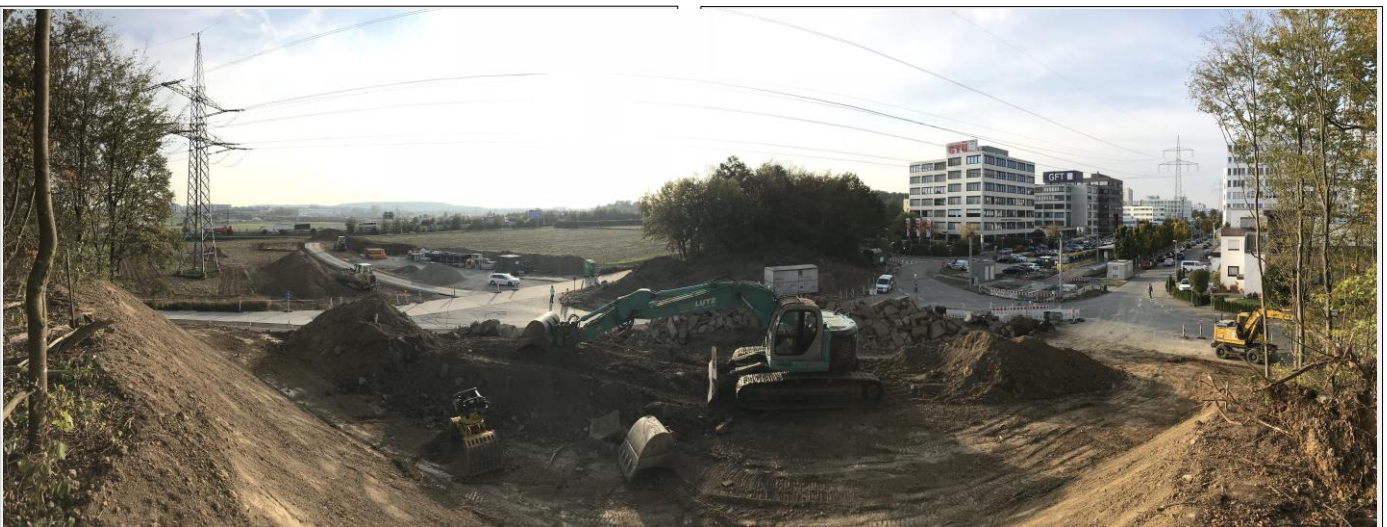
Links: Baustelleneinrichtung für den Neubau Betriebsgebäude
