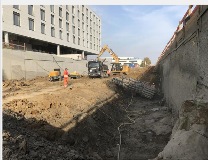
Anker- und Aushubarbeiten am Baugrubenverbau
