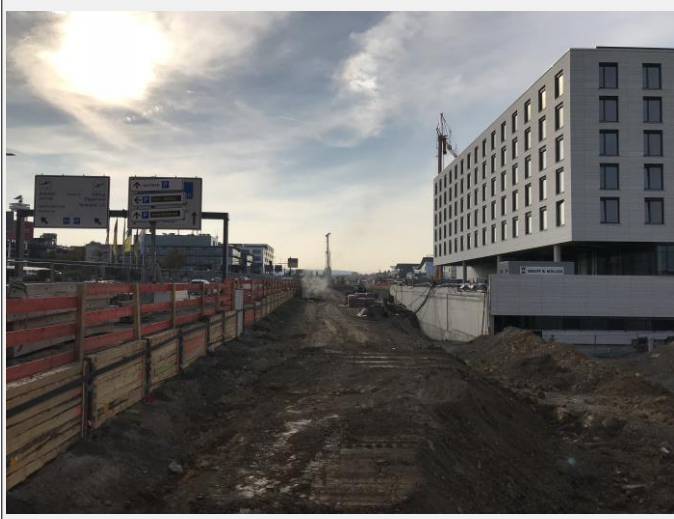
Baufeld im Bereich Endhaltestelle Flughafen/Messe
