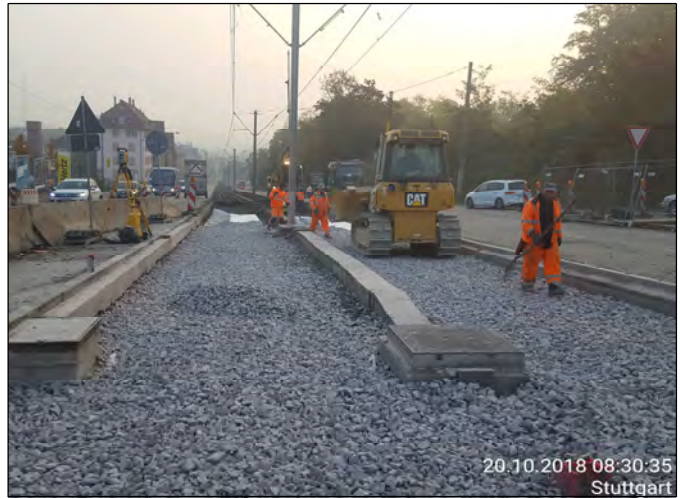
Bild 2: Einbau / Planie des Gleisschotters
