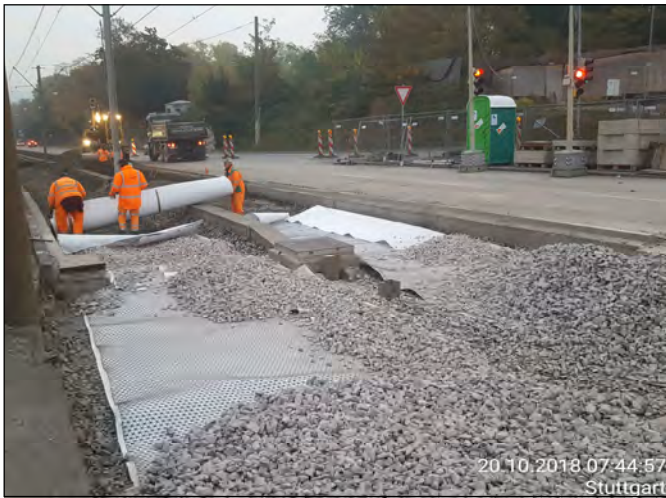
Bild 1: Herrichten der Gleisbereichs
