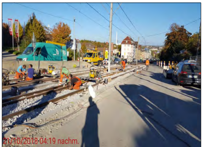
Bild 6: Arbeiten im neu verlegten Gleisbereich
