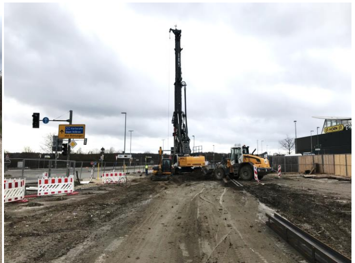
Restliche Bohrungen für die Baugrube an der Tunnelrampe
