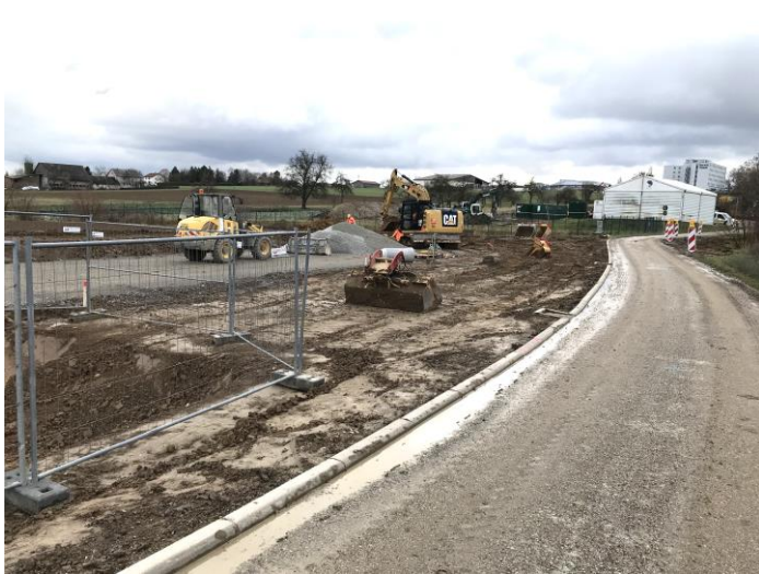
Streckenbau im Bereich der Bachquerung Erlenbrunnen
