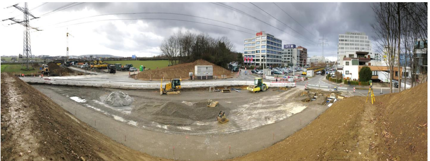
Links: Baustelleneinrichtung für den Neubau Betriebsgebäude
