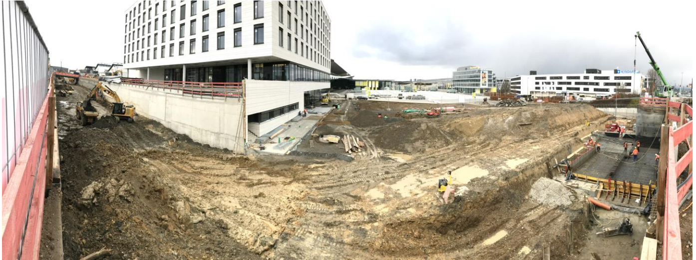
Links: Hilfsbrücke Hotel u. Baufeld Endhaltestelle Flughafen/Messe
