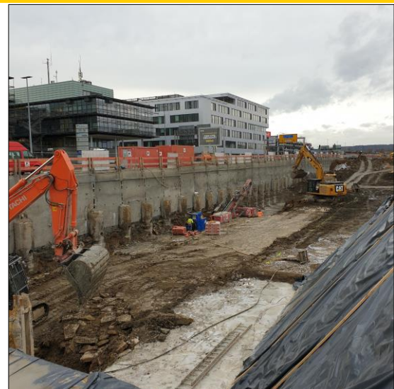
Aushubarbeiten im Bereich des Tunnelbauwerks
