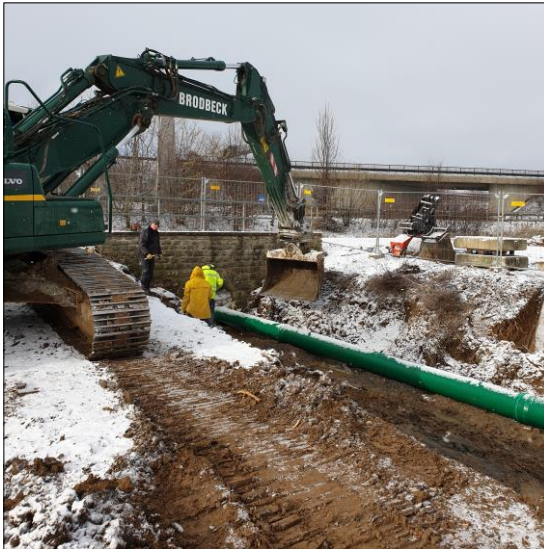
Aushubarbeiten an der Bachquerung Erlenbrunnen
