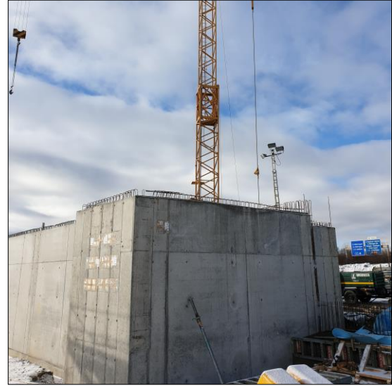
Herstellung Betriebsgebäude Unterwerk A8
