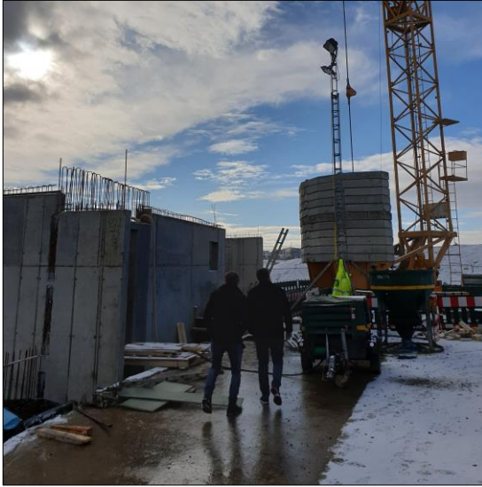
Herstellung Betriebsgebäude Unterwerk A8
