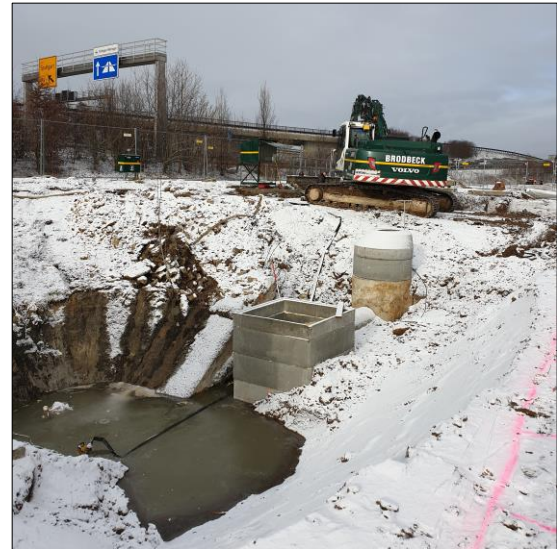
Herstellung Regenrückhaltebecken
