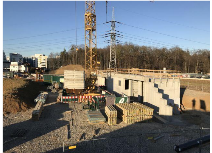
Fertigstellung Rohbau Betriebsgebäude Unterwerk A8
