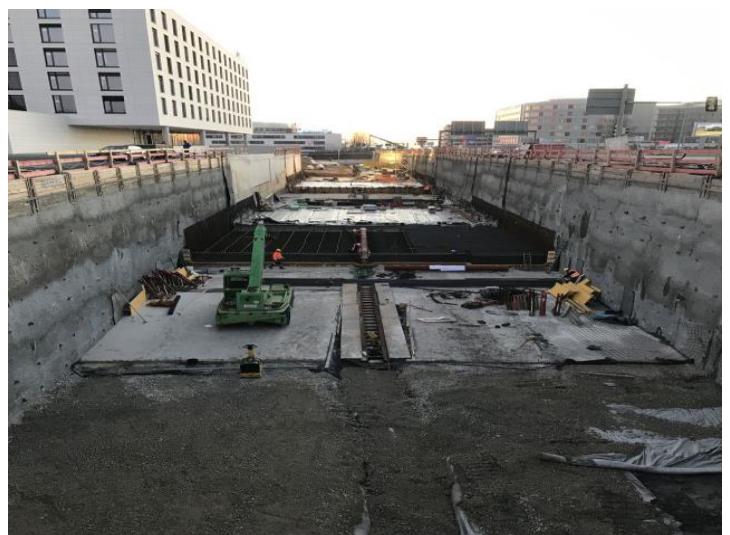
Bewehrung der Bodenplatten im Bereich der Endhaltestelle
