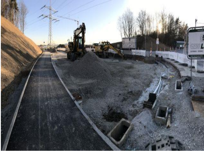
Herstellung Gehweg- und Straßenbau Schelmenwasenstraße
