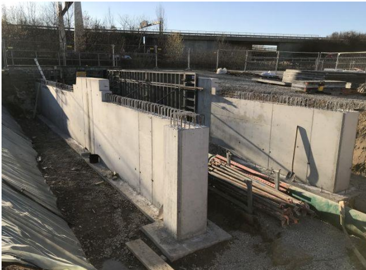
Stahlbetonarbeiten an der Bachquerung Erlenbrunnen
