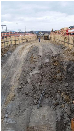
Erdaushub und Verbauarbeiten im Tunnelbereich
