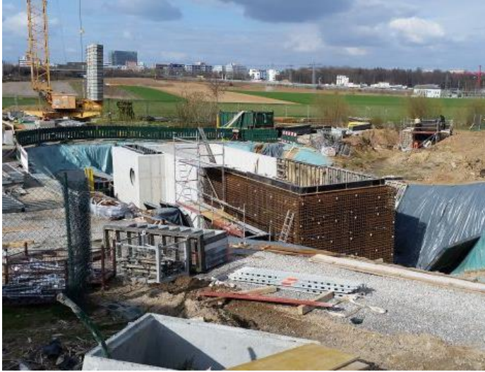
Stahlbetonarbeiten am Regenrückhaltebecken B27
