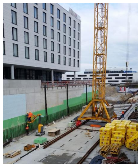
Einrichtung fahrbarer Kran im Bereich Endhaltestelle
