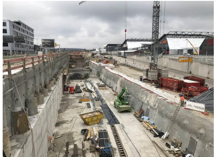
Blick in die Tunnelbaugrube
