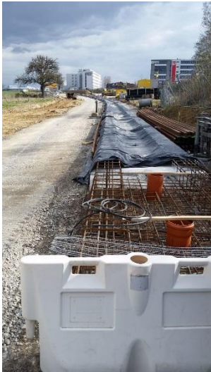
Betonage Feste Fahrbahn erster Abschnitt entlang B27
