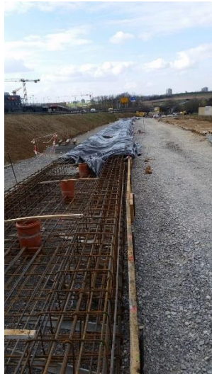
Betonage Feste Fahrbahn erster Abschnitt entlang B27
