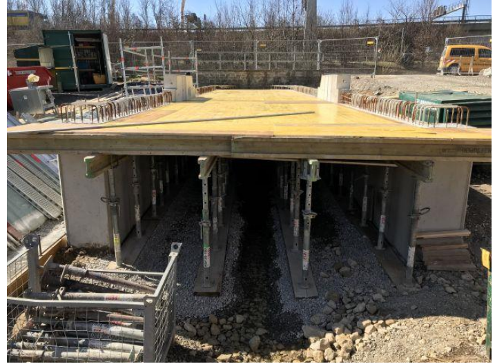
Schalungsarbeiten an der Bachquerung Erlenbrunnen
