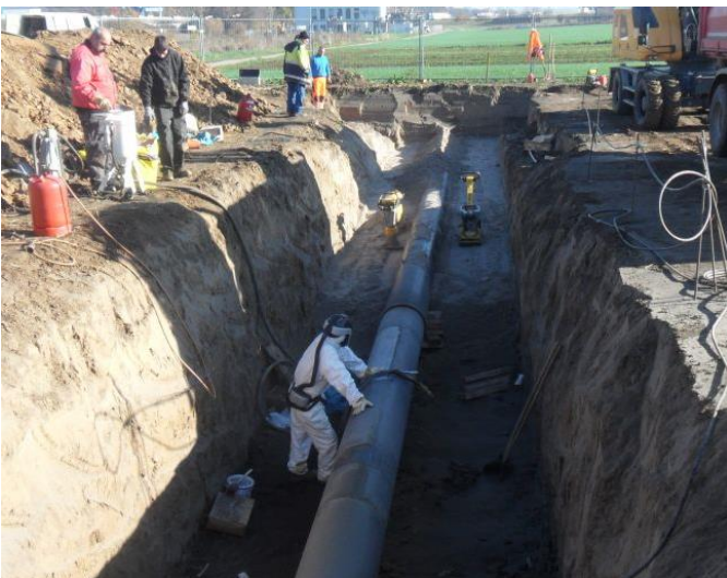
Ertüchtigung Gasleitung am Streitgraben
