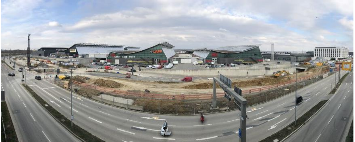
Gesamtüberblick über die Baustelle im Bereich der Flughafenstraße
