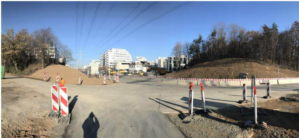
Straßenbauarbeiten im Bereich Schelmenwasen
