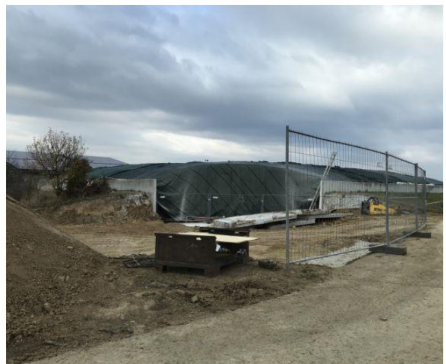
Arbeiten an der Biogasanlage
