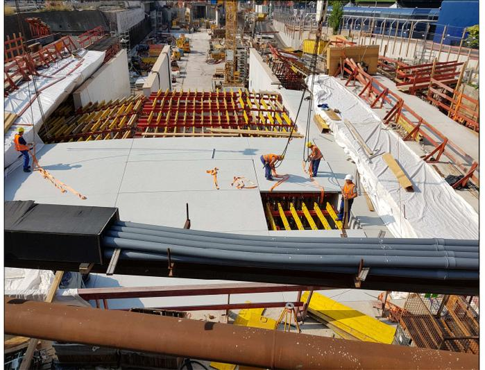
Deckenschalung für das Betonieren des Schalendachs
