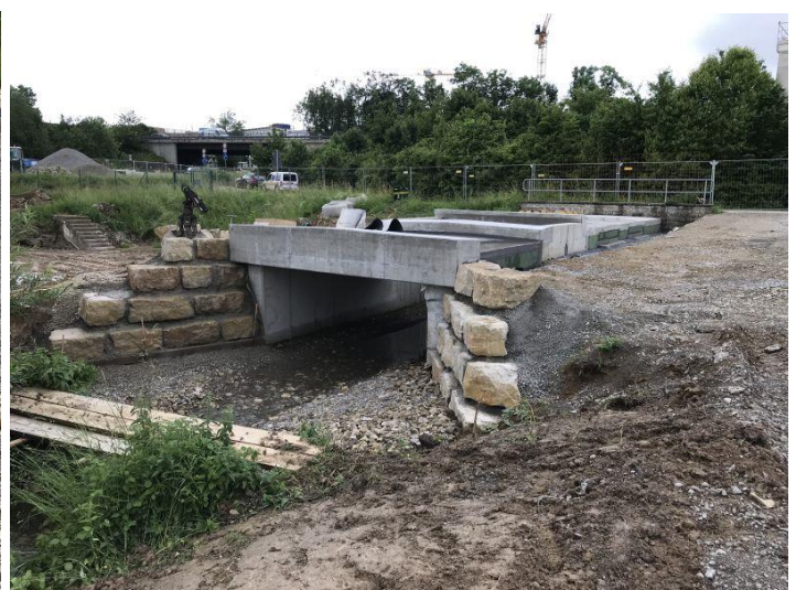
Herstellung Regenrückhaltebecken und Bachquerung Erlenbrunnen entlang der B27
