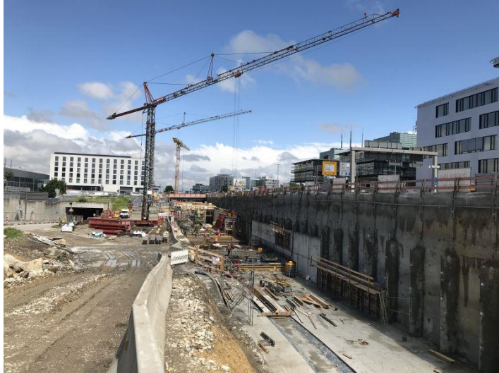
Tunnelbaugrube am Flughafen
