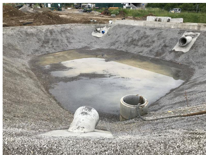
Herstellung Regenrückhaltebecken und Bachquerung Erlenbrunnen entlang der B27
