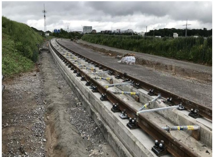
Gleisbau entlang der B27
