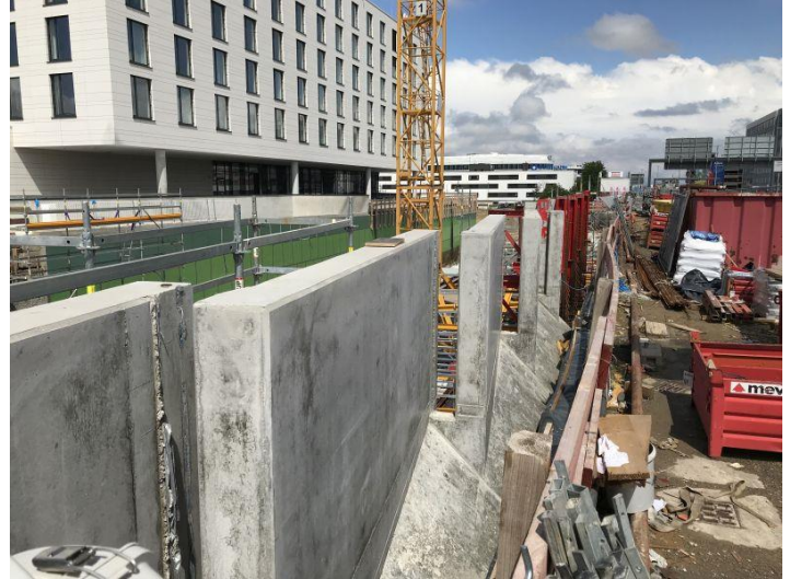
Herstellung der Schuppenwände am Flughafen
