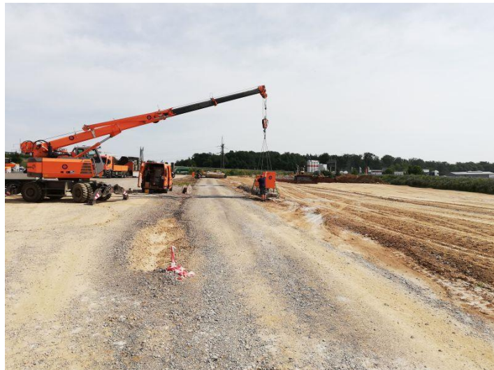
Beginn Herstellung Montagedamm Brücke A8
